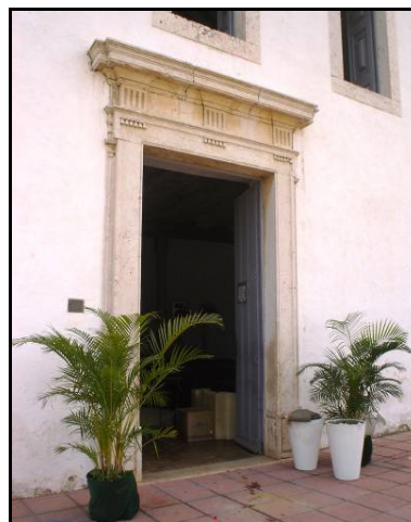
Fig. 32. Detalhe da porta de principal da nave da igreja e janelas do coro. Fonte: Foto da autora.
