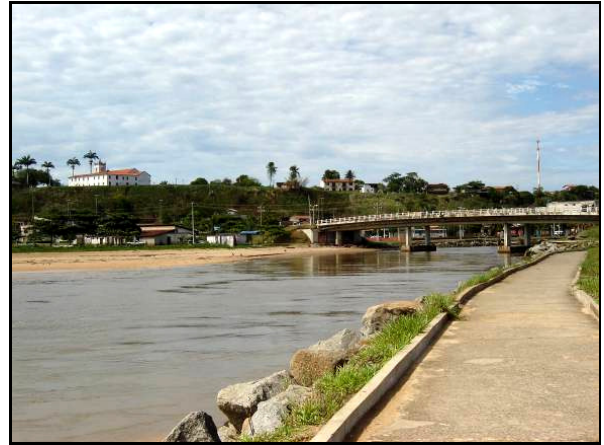
Fig. 57. Ponte sobre o rio Reis Magos e o complexo arquitetônico sobre a elevação, como guardião permanente. Fonte: Foto da autora.
