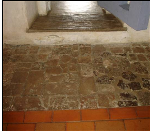
Fig. 40. Detalhe do piso do saguão de entrada, em direção a sala de exposição arqueológica. Fonte: Foto da autora.
