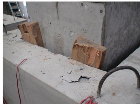
Figura 4.23 - Parede transversal frontal após encunhamento
