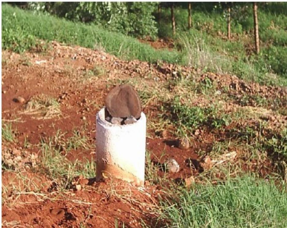
**Figura 65** - Canalização do gás metano no aterro sanitário do município de Xanxêre.
