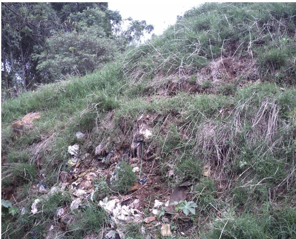
**Figura 37** - Resíduos expostos com cobertura ineficiente do aterro desativado na Linha Olinda.
