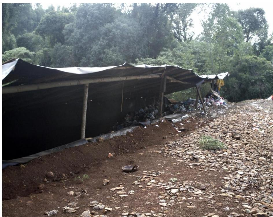
**Figura 60** - Vala séptica com impermeabilização e cobertura, no município de Serra Alta.
