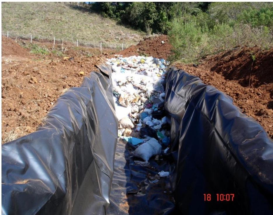
**Figura 62** - Vala séptica com impermeabilização no município de Sul Brasil.
