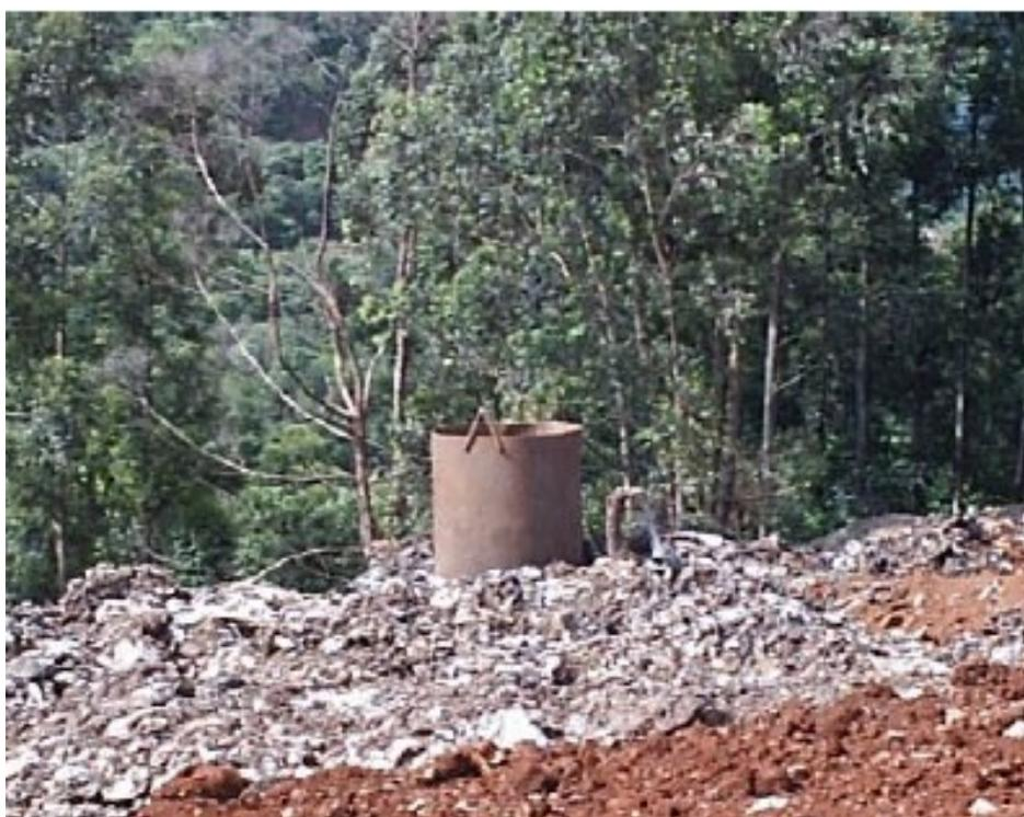
**Figura 19** - Sistema de drenagem de gases do lixão em Chapecó.
