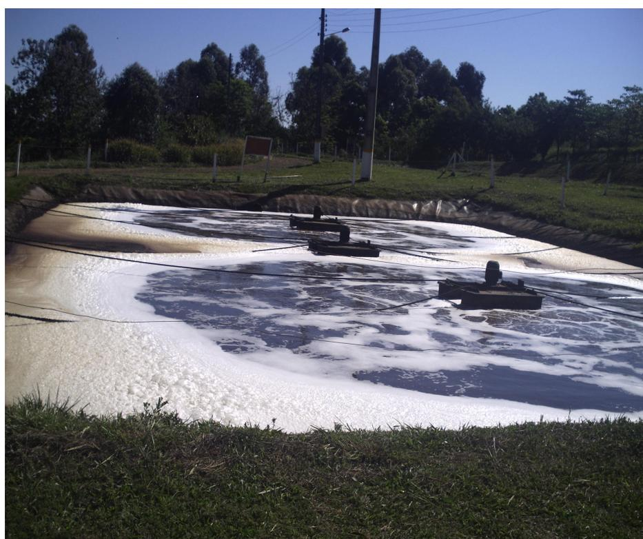
**Figura 22** - Sistema de lagoas de estabilização do aterro em Chapecó
