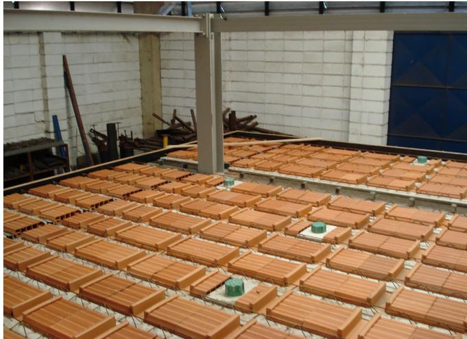
Figura 3.7 – Vista da laje pré-moldada bidirecional
