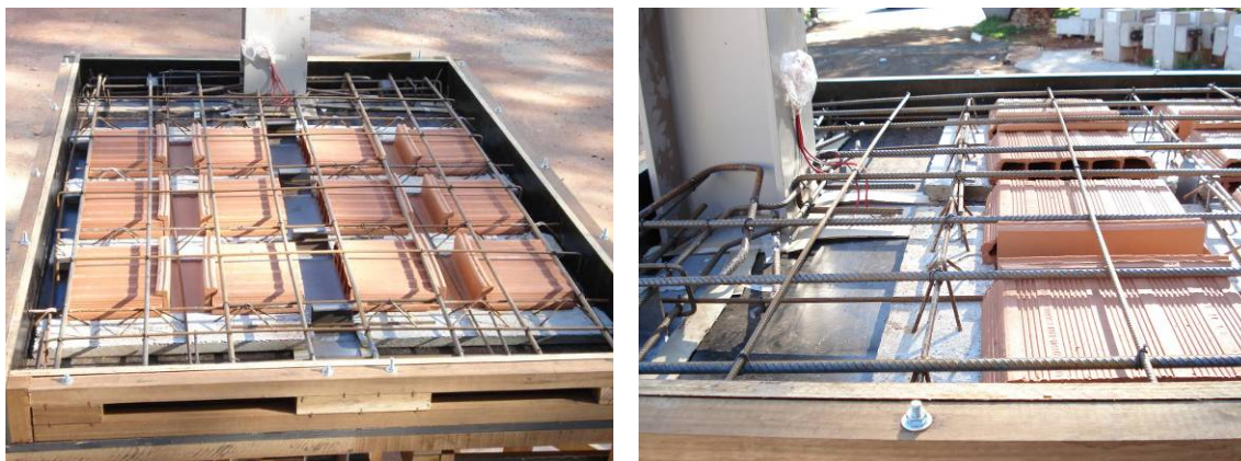
Figura A.9: Montagem da laje do protótipo TNRSS antes da concretagem.
