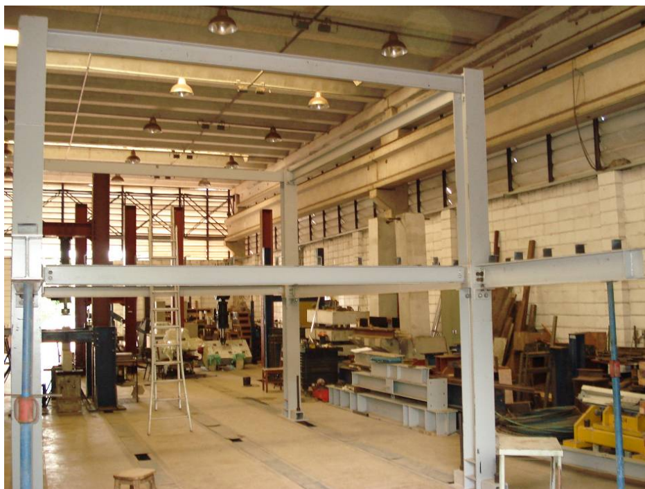
Figura 4.24: Visão geral da estrutura metálica do pavimento tipo.
