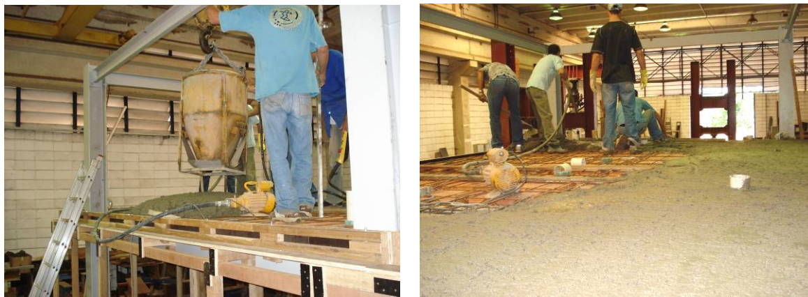
Figura 4.28: Sequência de concretagem do pavimento tipo.
