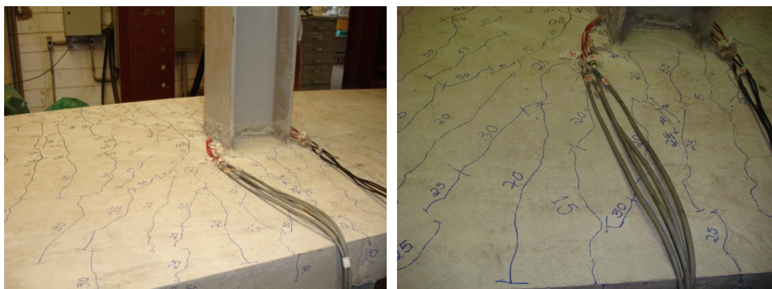
Figura 5.24: Fissuração na laje do modelo CRSS ao término do carregamento.
