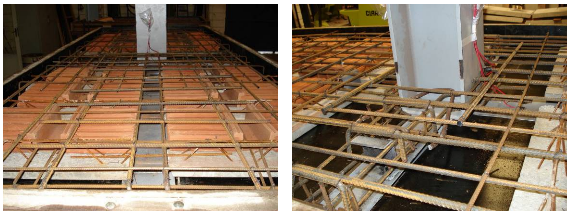
Figura A.6: Montagem da laje do protótipo CRSS antes da concretagem.
