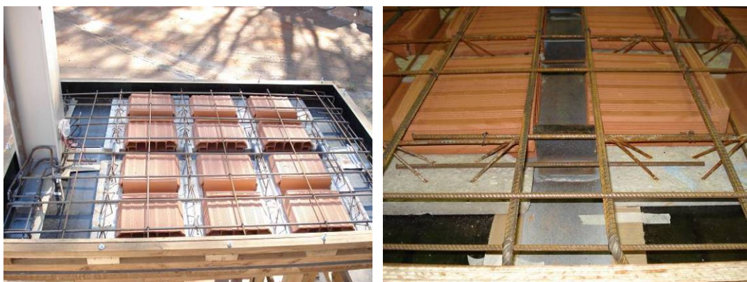
Figura 4.9: Disposição das armaduras do protótipo TNRSS antes da concretagem e detalhe da continuidade da armadura das vigotas.
