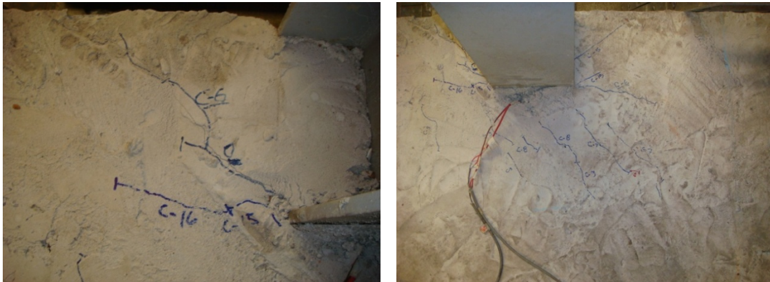
Figura 5.33: Fissuração da laje de concreto na Lig. [1] após o ensaio.
