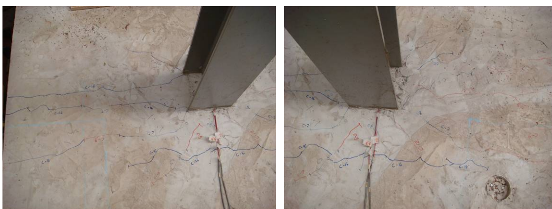
Figura 5.41: Fissuração da laje de concreto na Lig. [3] após o ensaio.
