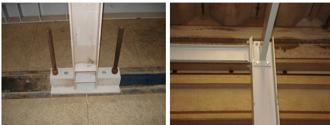
Figura 4.23: Detalhe da base do pilar e das vigas de contraventamento.
