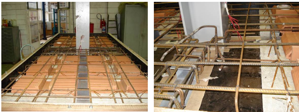
Figura A.3: Montagem da laje do protótipo CNRSS antes da concretagem.
