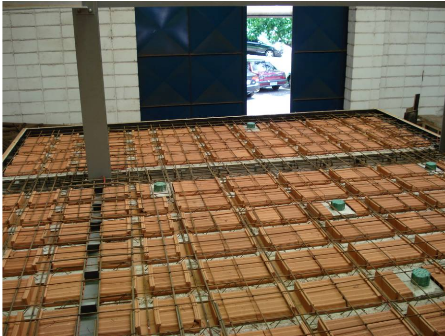
Figura 4.27: Visão geral do pavimento tipo antes da concretagem.
