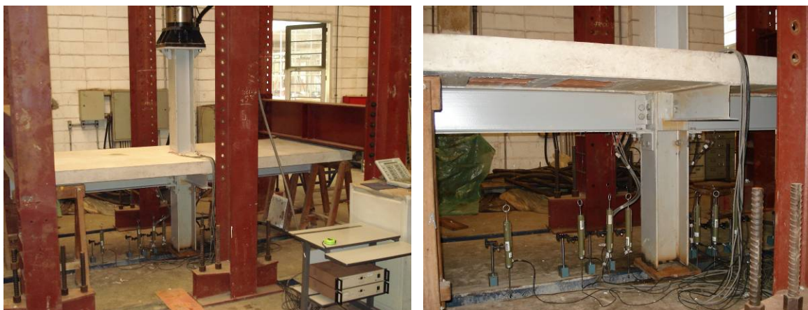
Figura 4.12 – Visão geral do protótipo isolado de pilar de centro.
