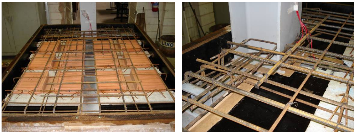
Figura A.12: Montagem da laje do protótipo TRSS antes da concretagem.
