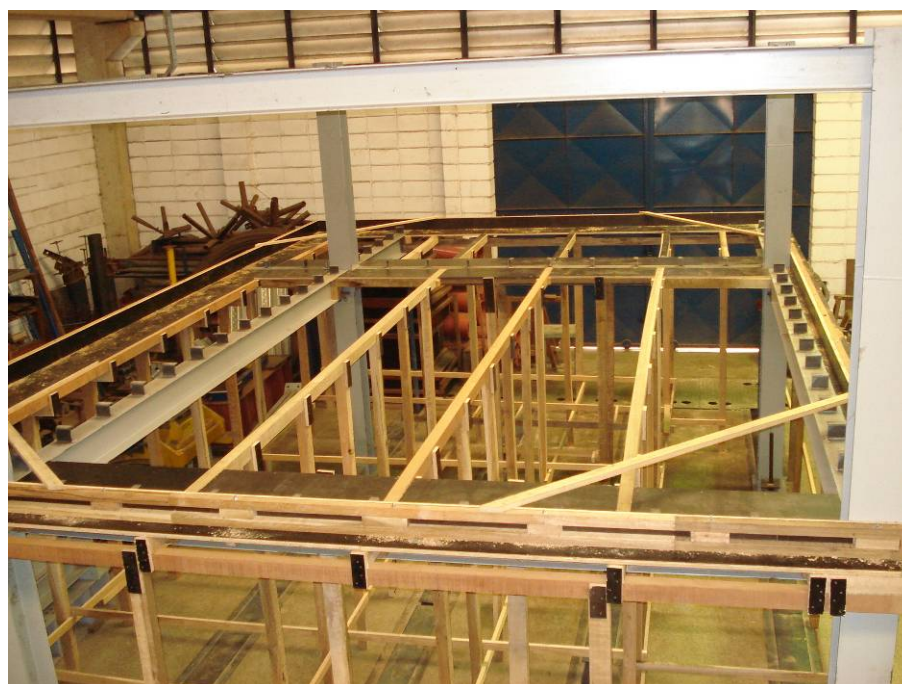
Figura 4.26: Visão geral do pavimento tipo após a montagem das formas.
