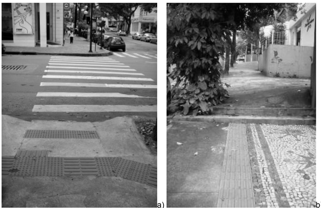
FIGURA 149 – Descontinuidades de condições adequadas de mobilidade em calçadas
