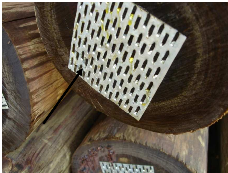
FIGURA 4.18 – Chapa de dente estampado na base do poste
