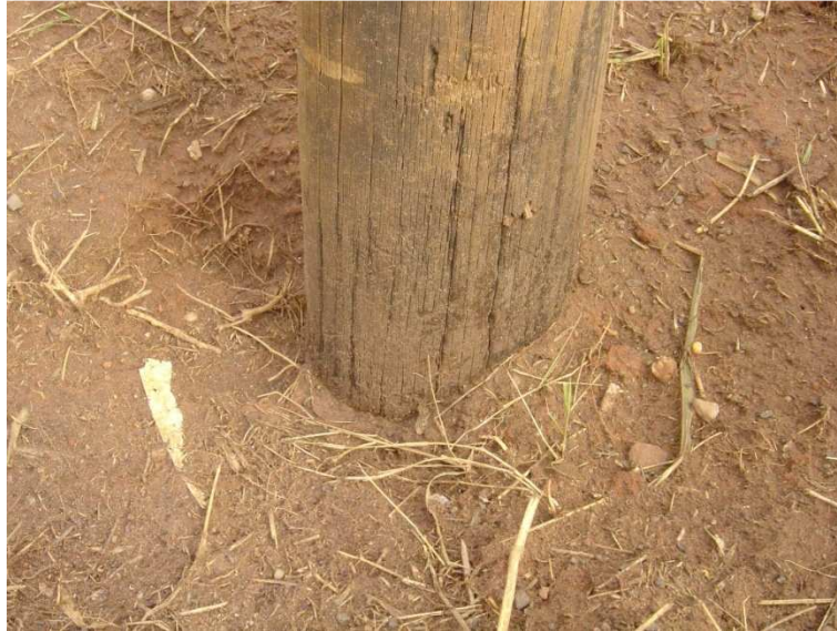
FIGURA 4.1 – Região de afloramento do poste
