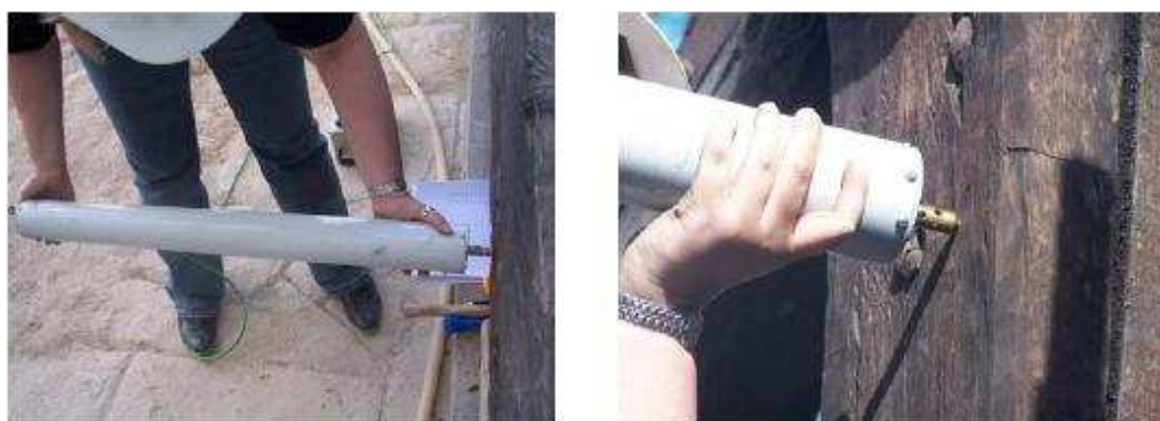
FIGURA 4.11 – Uso de equipamento de perfuração controlada na avaliação de tesoura – (VALLE et al.; 2006)
