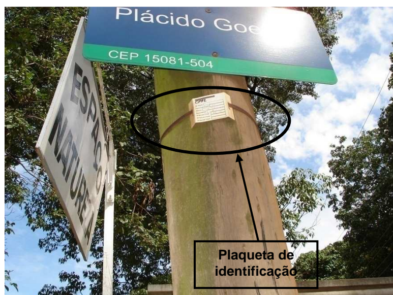
FIGURA 10.1 – Plaqueta de identificação dos postes
