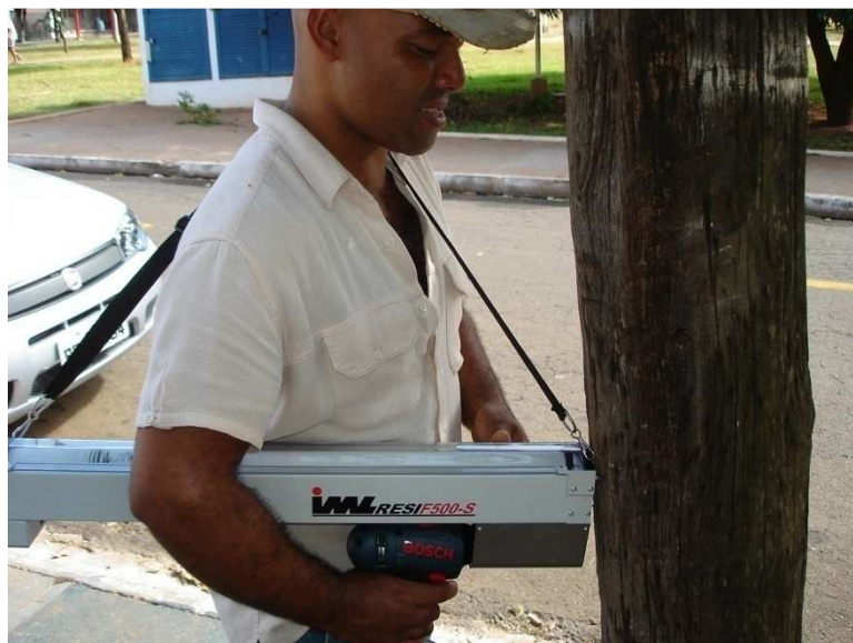
FIGURA 10.3 – Equipamento de perfuração controlada IML-RESIF500-S
