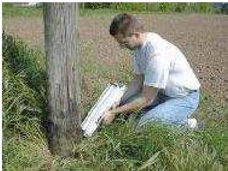
FIGURA 4.10 – Uso do Resistograph® na avaliação de postes de madeira
