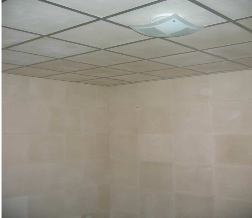
Figura 16. Detalhe das paredes e do forro do novogesso em um dos dormitórios.(Fonte: Imagem cedida pela Inovamat Ltda)
