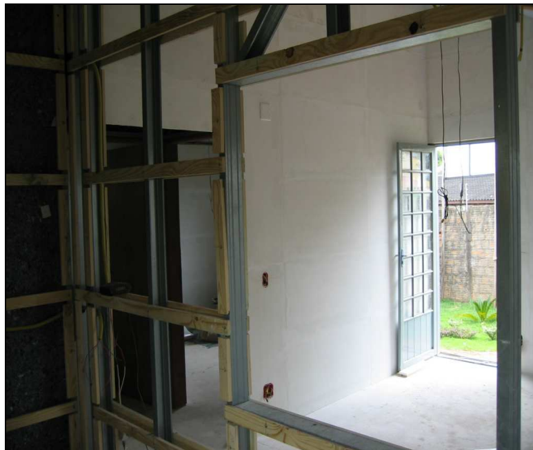
Figura 11. Detalhe do fechamento das paredes com placas do novogesso, parafusadas em barrotes de madeira e nos perfis da estrutura metálica “Light Steel Frame”. (Fonte: Imagem cedida pela Inovamat)
