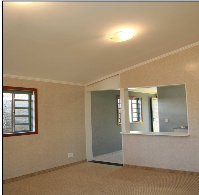
Figura 14. Detalhe do acabamento das paredes da sala de estar e cozinha ao fundo. (Fonte:Imagem cedida pela Inovamat)
