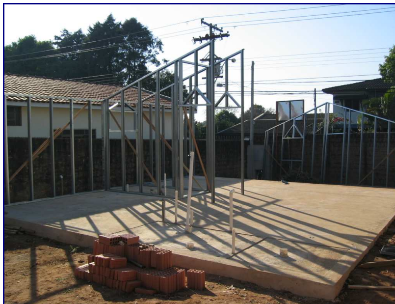
Figura 9. Detalhe da fundação tipo radier e início da colocação dos perfis metálicos para compor estrutura da parede. (Fonte: Imagem cedida pela Inovamat)
