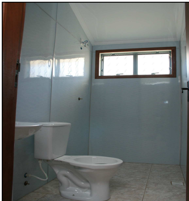
Figura 15. Detalhe do acabamento das paredes do banheiro.(Fonte: Imagem cedida pela Inovamat)
