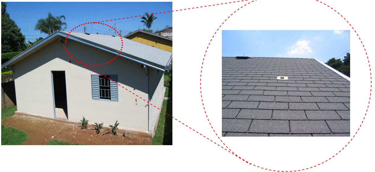
Figura 13. Detalhe da cobertura; Detalhe das telhas “shingle”. (Fonte: Imagem cedida pela Inovamat)
