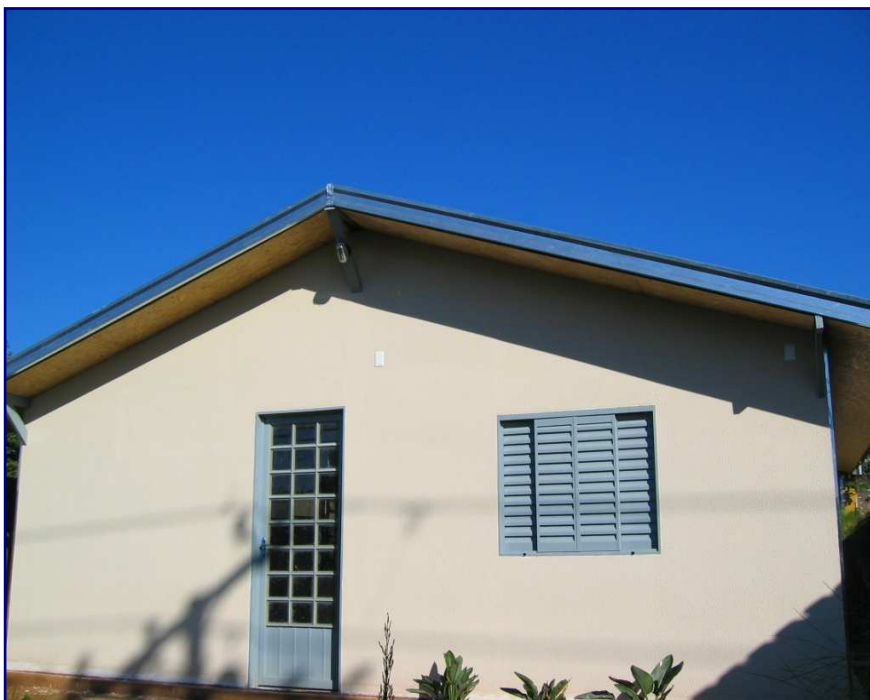
Figura 1. Casa experimental construída com placas do Novogesso (Fonte: Imagem cedida pela Inovamat – Inovação em Materiais Ltda. São Carlos - SP)
