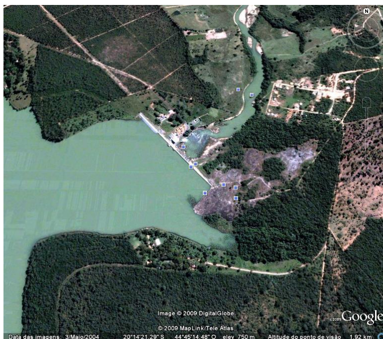
Figura 3: Usina Hidrelétrica (UHE) de Cajuru, Carmo do Cajuru, Minas Gerais. Instalada no rio Pará com início de operação em 1959. Tem potência de 7,2MW e volume útil de 132,00hm 3 .
