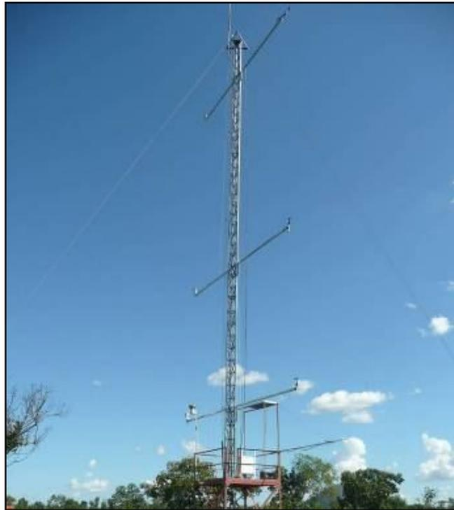
**FIGURA 3.** Torre micrometeorológica instalada na Fazenda Miranda, em Santo Antônio de Leverger, MT.
