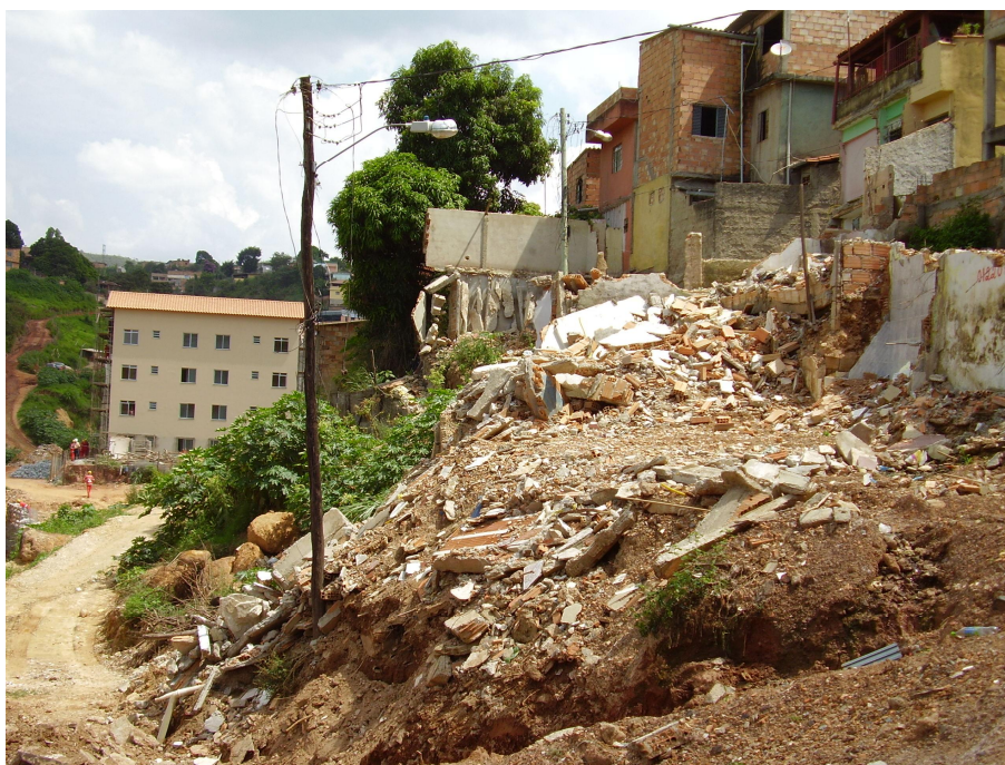
Foto 11: Imagens da varredura: Sobras da derrubada de casas e barracos para a implementação do "Vila Viva/Santa Terezinha. Ao fundo, prédio que faz parte do Condomínio Santa Tereza, já em fase final de construção. Autor: Luiz Antônio E. de Andrade. Data: 06/12/09.
