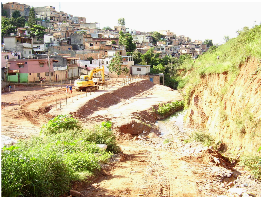
Foto 09: Detalhe da área – localizada na Vila “Buraco do Sapo” – que está recebendo as “intervensões” do “Programa Vila Viva/Santa Terezinha”. Autor: Luiz Antônio E. de Andrade. Data: 03/10/09.
