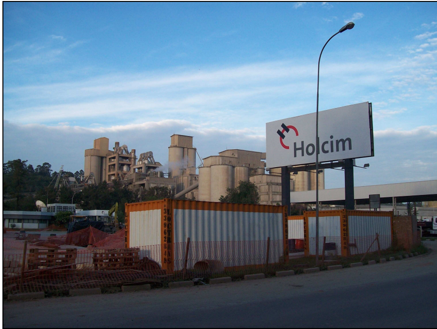
Figura 4.2 – Vista da portaria principal da Holcim, em Pedro Leopoldo
