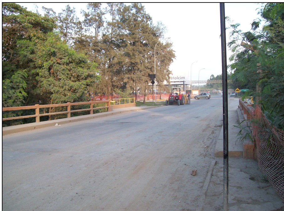
Figura 4.3 – Ponte sobre o Ribeirão da Mata – acesso à portaria principal da Holcim, em Pedro Leopoldo
