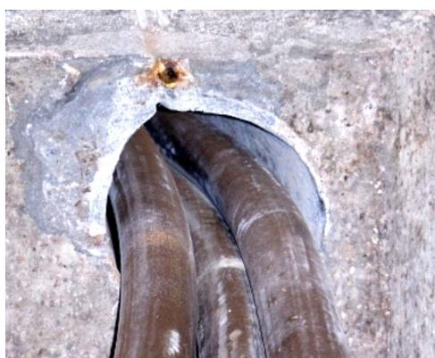
Figura 3.2: Duto e cabos de uma distribuição subterrânea de energia.
