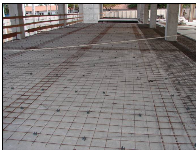
Figura 2.19: Distribuição das telas soldadas para posterior concretagem da capa.
