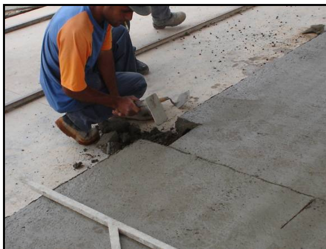
Figura 2.6: Execução de um recorte de pilar em concreto fresco.
