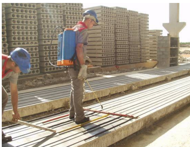
a) Aplicação de desmoldante com pulverizador.
