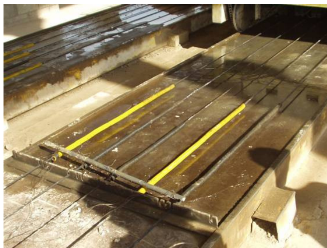
b) Proteção das cordoalhas durante a aplicação de desmoldante.
