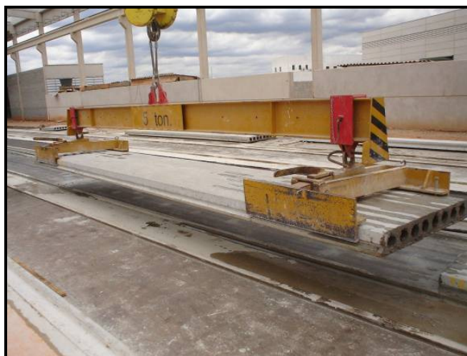
Figura 2.11: Içamento das lajes utilizando o sistema de garras e balancins.
