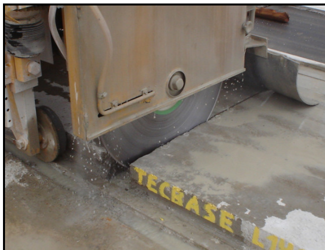
a) Execução de um corte transversal na laje.
