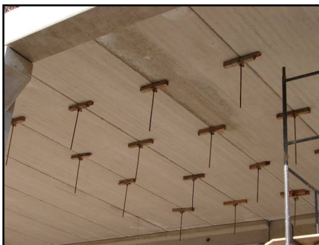
a) Posicionamento dos torniquetes para equalização das lajes.
