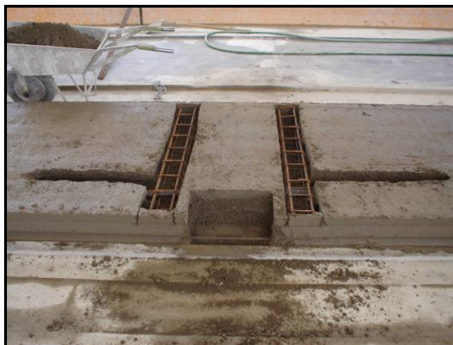
Figura 2.7: Reforço no recorte de pilar feito na pista.
