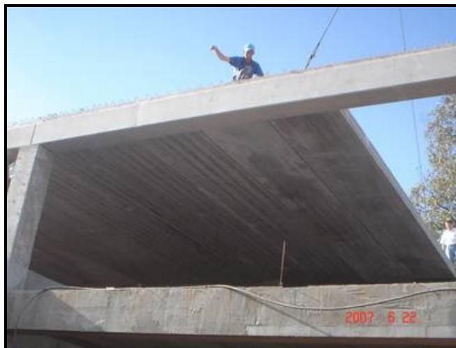
b) Posicionamento de um painel alveolar.
