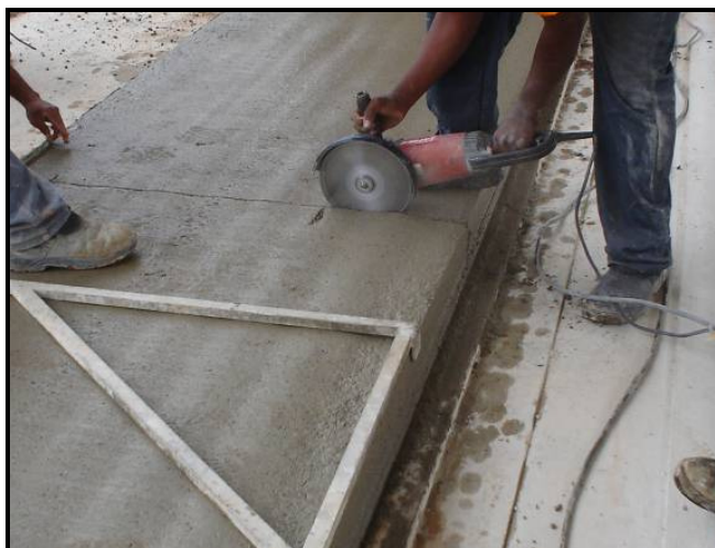
Figura 2.8: Execução de um recorte de pilar no painel com concreto fresco.
