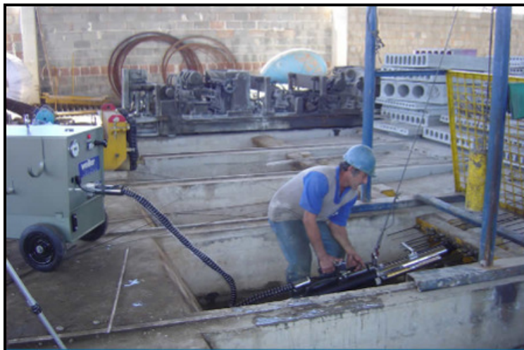
Figura 2.3: Funcionário posicionando o macaco que protende cada cordoalha isoladamente.
