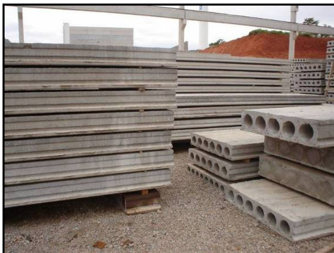
a) Pilha de lajes estocadas com calços alinhados.
