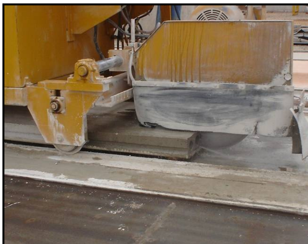
b) Execução de um corte longitudinal na laje.
