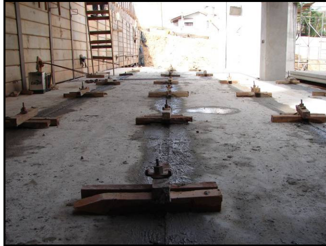
b) Grauteamento das chaves de cisalhamento.
