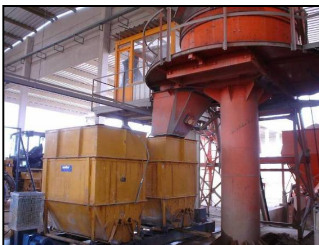
Figura 2.4: Usina de produção de concreto e caçambas posicionadas no carrinho de transporte.
