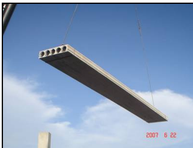
a) Içamento de uma laje alveolar.
