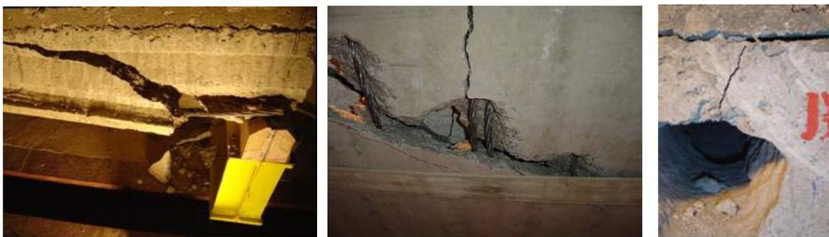
a) Fissuração na parte lateral; b) Fissuração da parte inferior; c) Vista frontal.
