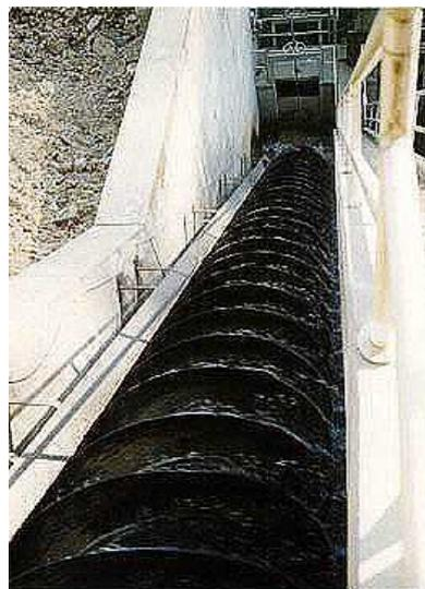
Figura 2 - Bomba de Arquimedes em Uma Estação de Tratamento de Água.
