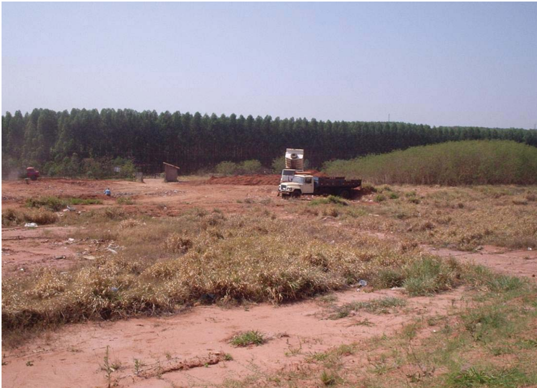
Foto 5.2.3 – Aterro em valas de Brotas. 2007
