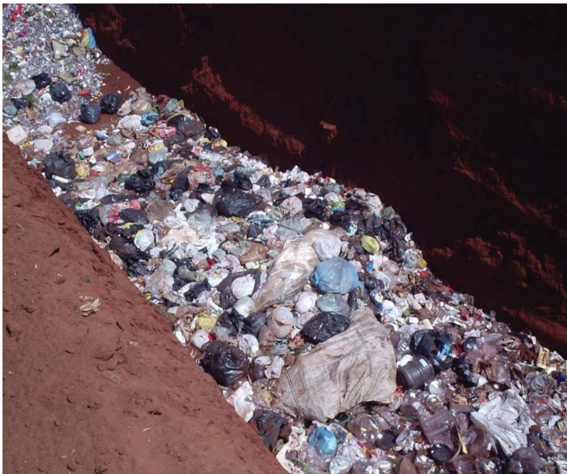
Foto 5.5.3– Aterro em valas de Ribeirão Bonito. 2007
