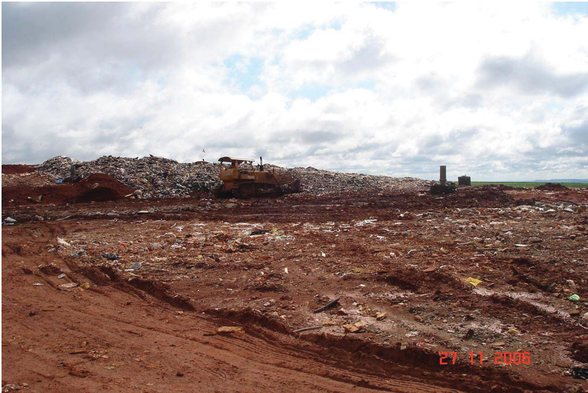
Foto 5.1.2 – Aterro controlado de Araraquara. 2006
