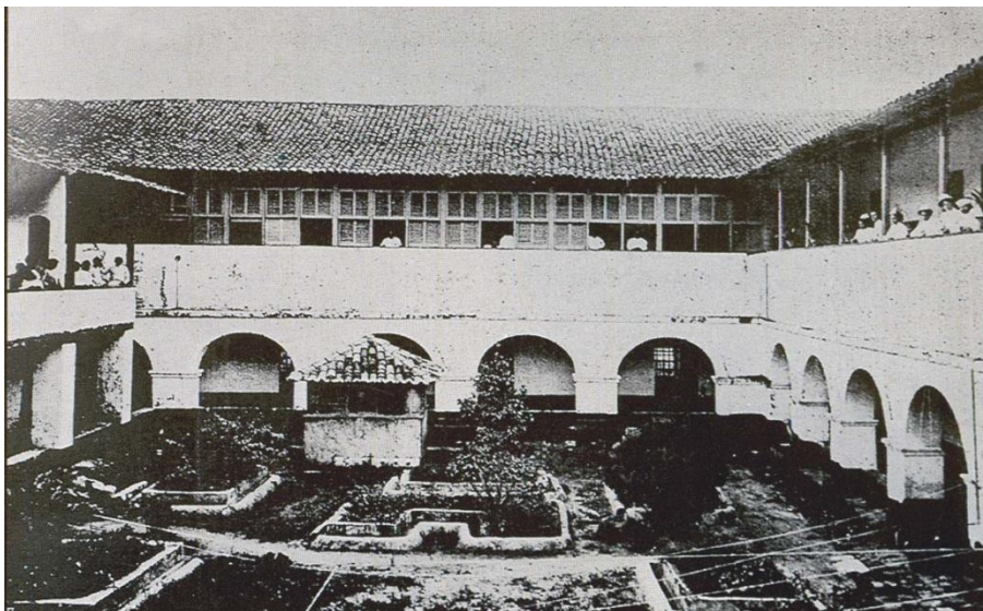
Figura 4 - Hospital de Isolamento do Maranhão, 1904.
