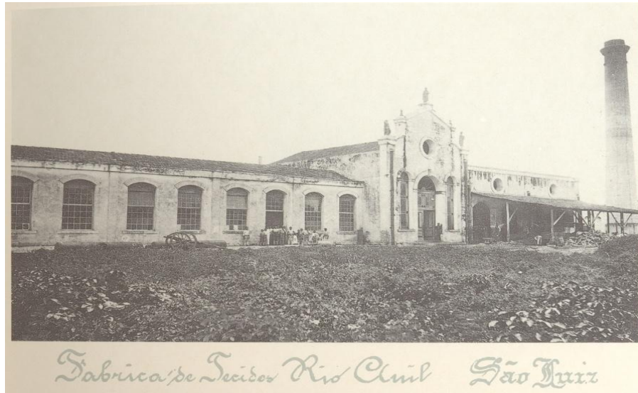
Figura 10 - Fábrica de Fiação e Tecidos Rio Anil.
