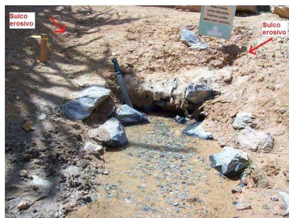
FIGURA 110 – Início de formação de pequenos sulcos erosivos a montante de N070.
