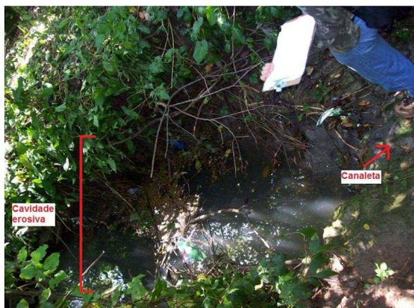
FIGURA 107 – Cavidade erosiva provocada pela concentração do escoamento pluvial (N066).
