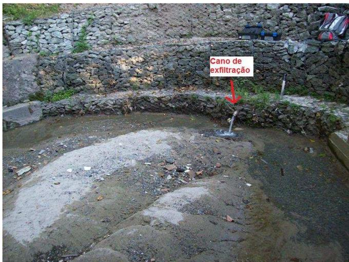
FIGURA 58 – Nascente em intervenção – bacia de detenção de sedimentos – no Parque Lagoa do Nado – N063.
