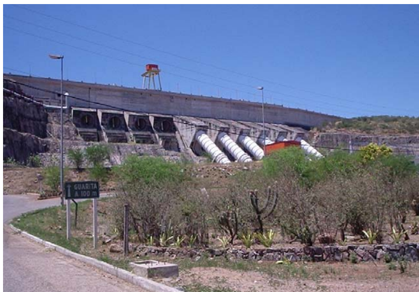
Figura 4.11 – Usina Hidrelétrica de Xingó, localizada entre Alagoas e Sergipe, com usina geradora composta de 6 unidades.
