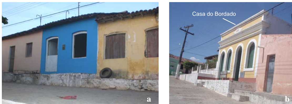
Figura 4.19 – Povoado Entremontes – Piranhas - AL: a. Casario tombado pelo IPHAN; b. Casa do Bordado de Entremontes. Fonte – Autor (Pesquisa de campo, 2008)
