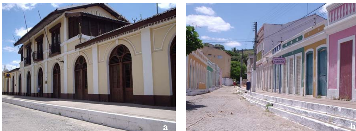
Figura 4.16 – Centro Histórico de Piranhas - AL: a. Antiga estação ferroviária, onde funcionam a SECTUR, biblioteca pública, loja de artesanato e o Museu do Sertão; b. casario e pontos comerciais, tombados pelo IPHAM.
