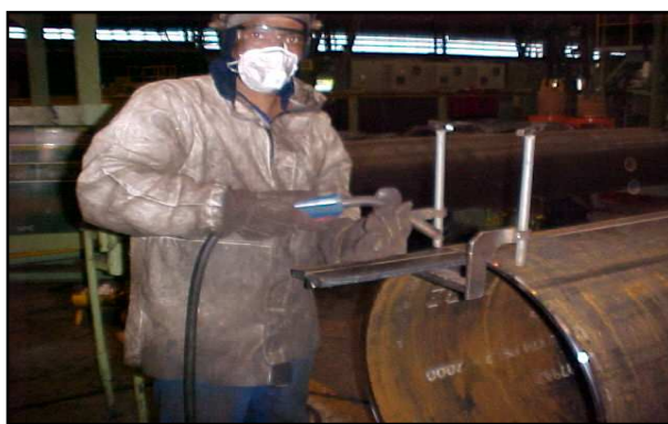
Figura 16 – Soldagem da chapinha por GMAW manual (Gentileza Tenaris Confab)
