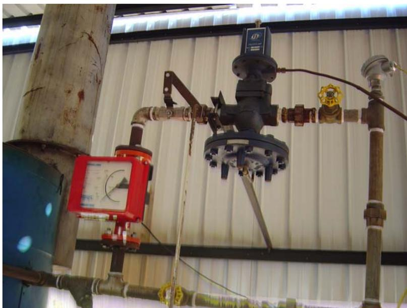
Figura 45 - Vista da válvula de controle de pressão.
