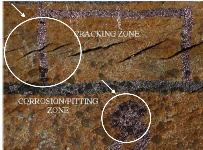
Figura 2.9 - Tubo API 5L X-65, com a presença de trincas e corrosão por pites próximo ao local de ruptura, após 19 anos de operação da tubulação (CHEN et al, 2009).
