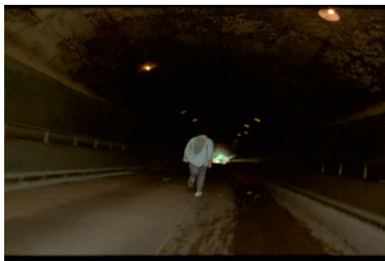
Foto 18: 0:06:18 – fuga pelo túnel
