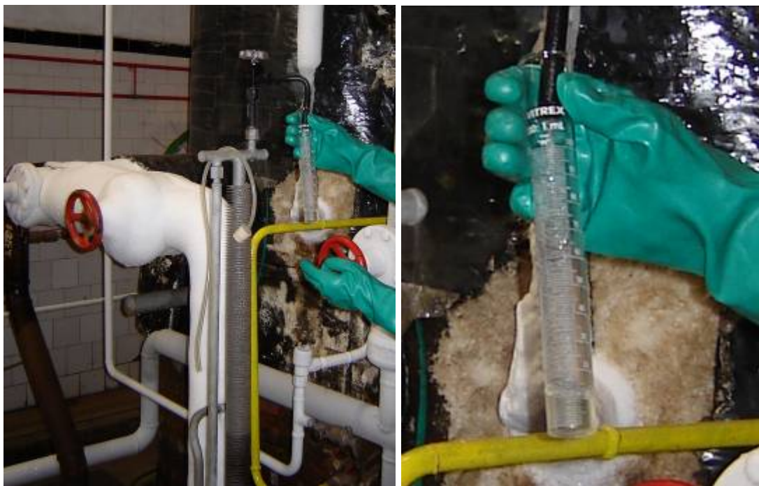
Figura 4.5 – Coleta do R-717 líquido
