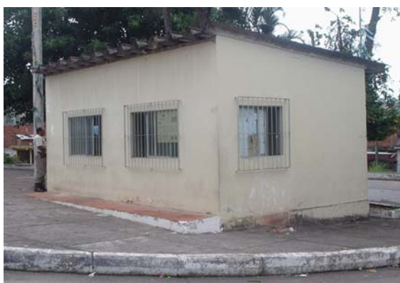
Figura 4 – Parte externa do módulo São João do Cabrito, Subúrbio Ferroviário de Salvador Fonte: Figura produzida pela autora (2006).
