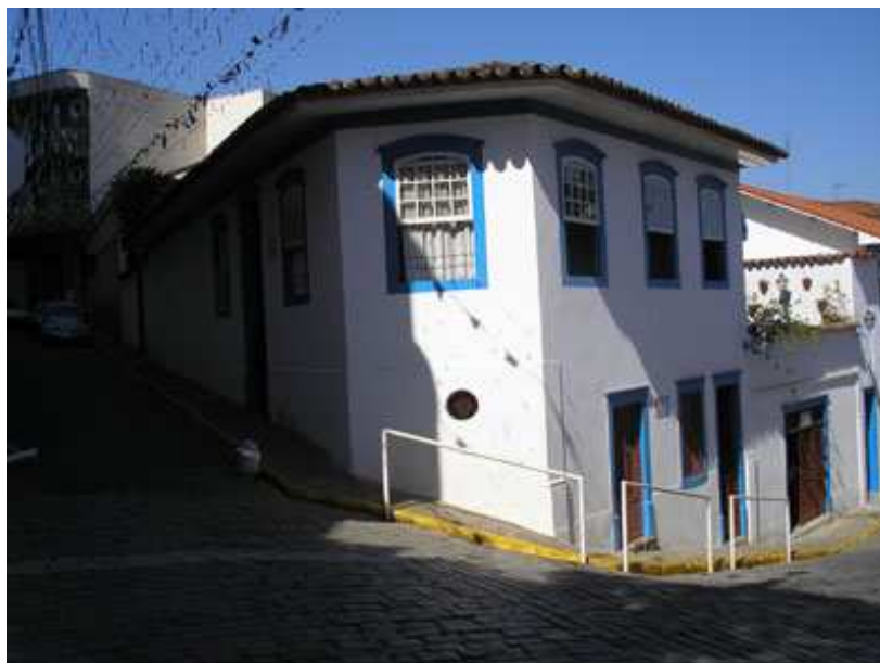
Ilustração 51 - Atual fachada da casa de frei Galvão.
