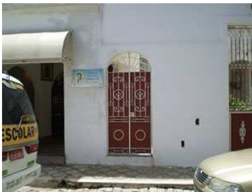
Ilustração 85 - Vista da entrada do átrio. O portão marrom dá visibilidade para o espaço da fonte; o toldo à esquerda é a entrada da loja.
