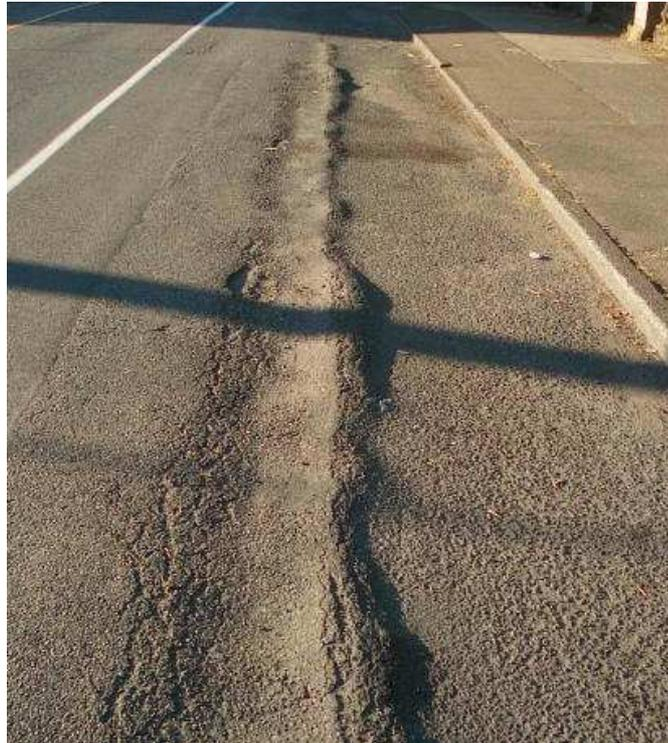
Figura 2.6: Exemplo de afundamento de trilha-de-roda de pavimento asfáltico em ponto de ônibus de vias urbanas.
