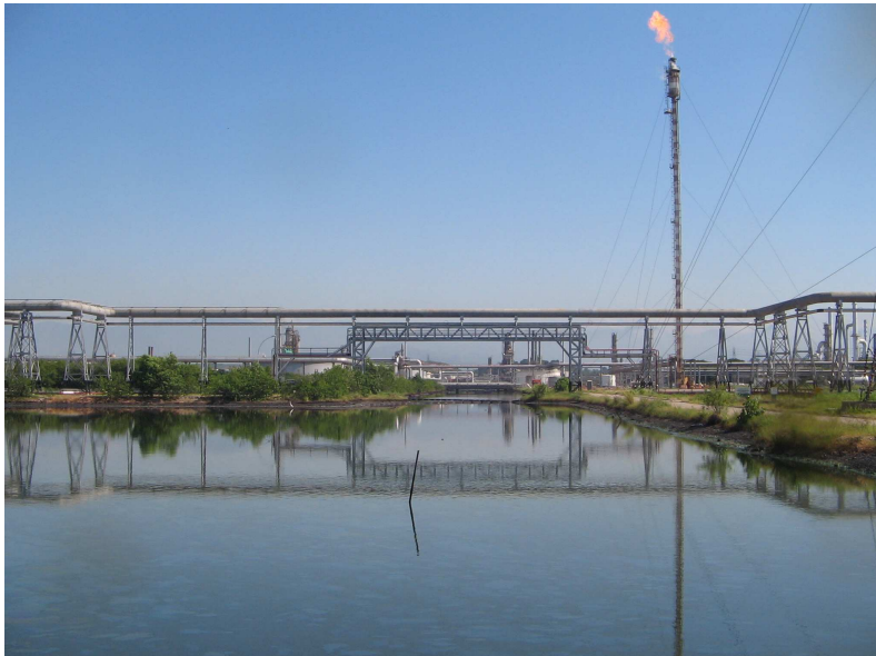
Figura 9: canal do “FLUME”. Fonte: Petrobras (2006).
