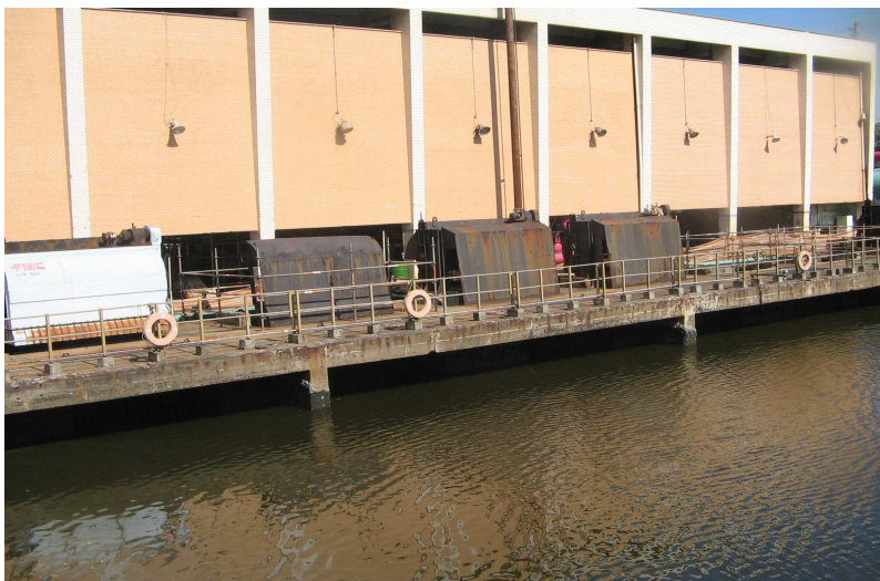
Figura 8: Casa de Bombas de Refrigeração Fonte: Petrobras (2006).
