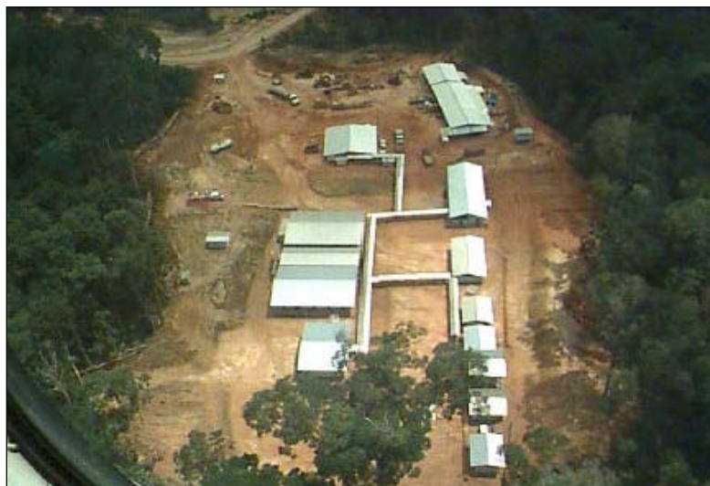
Figura 9 – Canteiro de obras Fonte: IENOR/FVS/INPA
