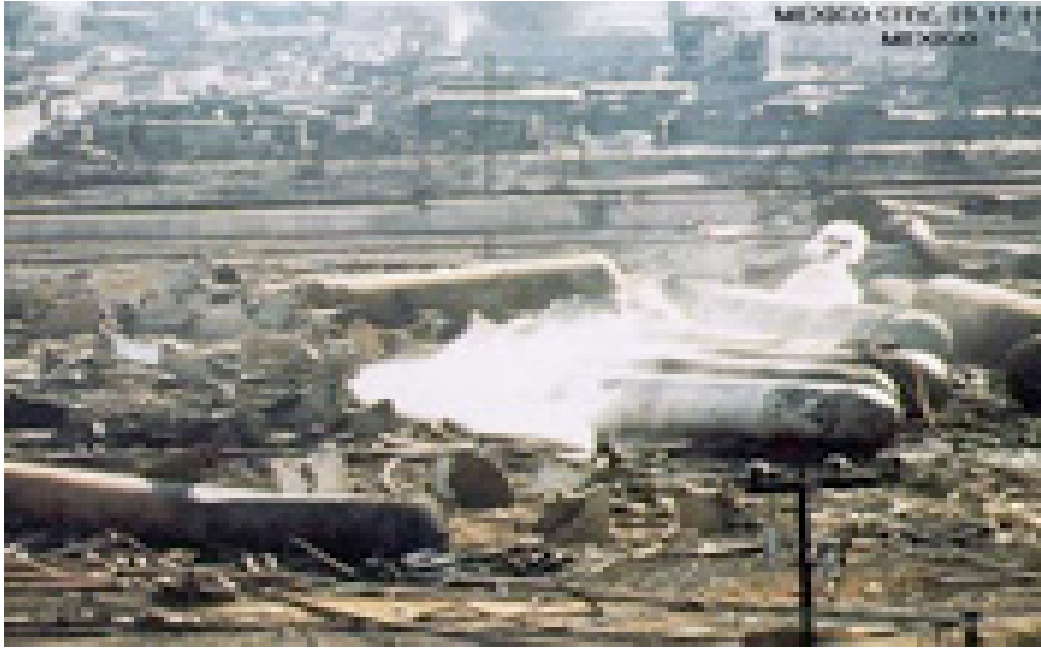
Figura 13: Planta da PEMEX na Cidade do México – Depois do acidente (c).
