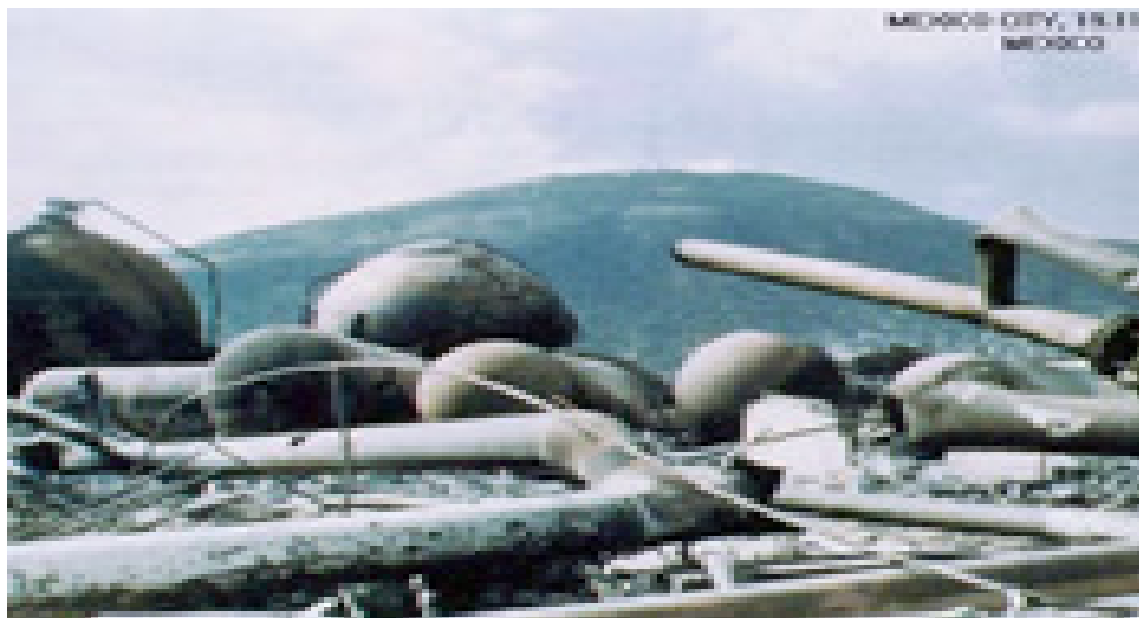
Figura 12: Planta da PEMEX na Cidade do México – Depois do acidente (b)
