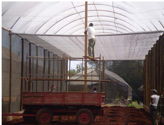
Figura 7 – Instalação da tela termo-refletora na altura do pé-direito, no interior do Ambiente I
