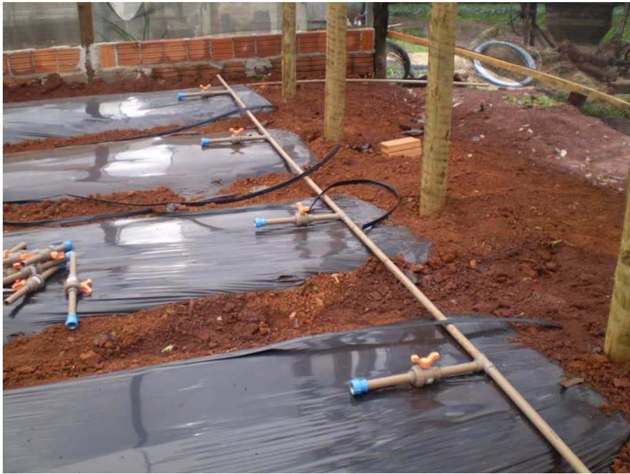
Figura 10 – Instalação dos sistema de irrigação, com os tubos gotejadores, os registros e as conexões, no interior do ambiente protegido
