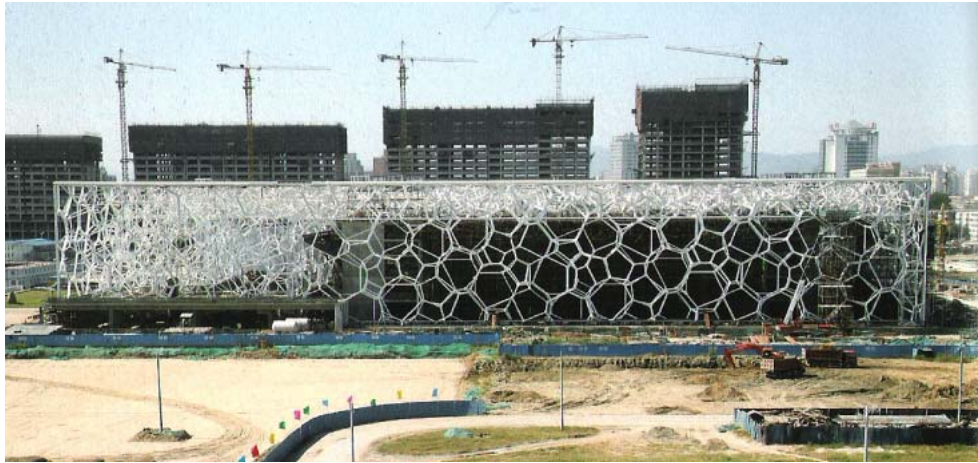
Figura 34 - Etapa de construção do Water Cube.
