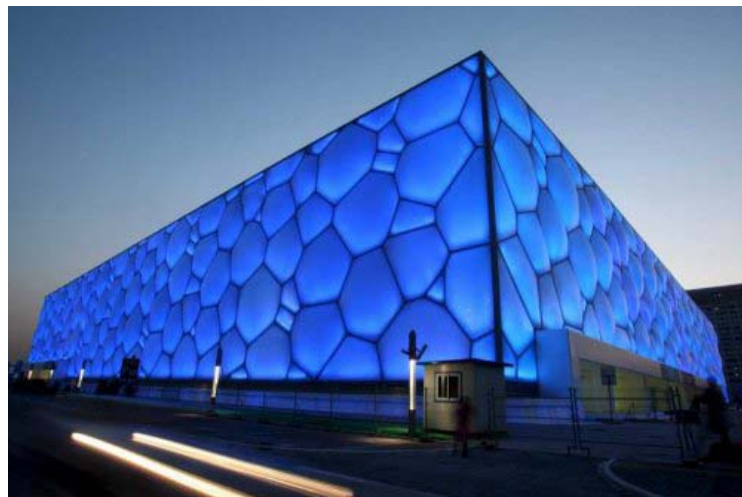
Figura 35 - Centro Aquático das Olimpíadas de Beijing. PTW architects .
