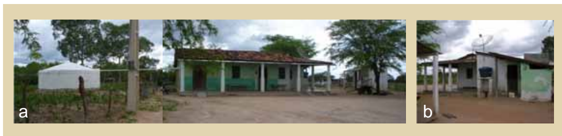
Figura 4.4 – Vista externa da propriedade da Fabriqueta 1
