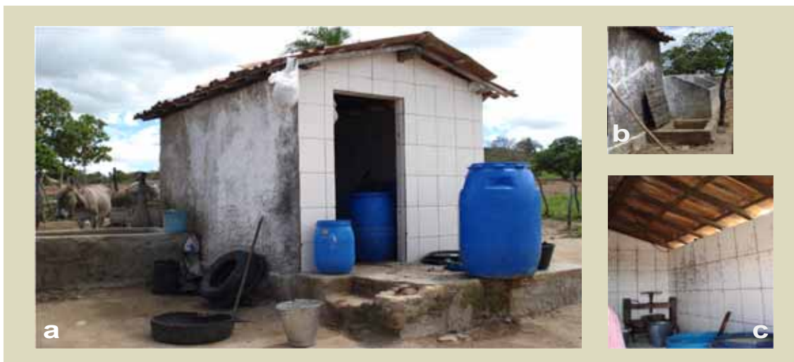
Figura 4.13 – Vista externa da Fabriqueta 2
