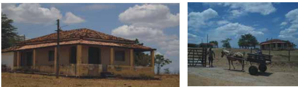
Fig. 3.4 – Sede de fazenda produtora de leite – município de Batalha , no semi-árido de Alagoas.
