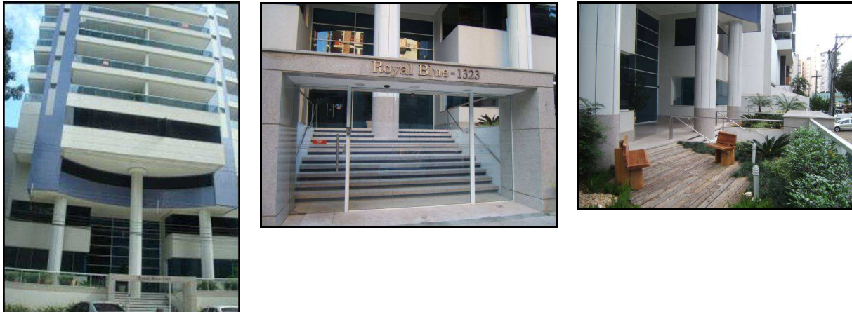
Figura 6: Edifício Royal Blue
