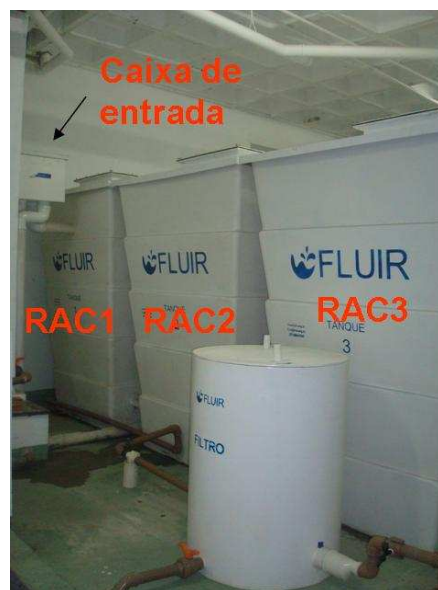
Figura 10: Reator Anaeróbio Compartimentado
