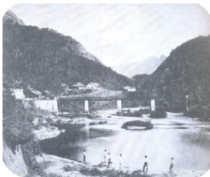
Figura 82: Ponte sobre o rio Santa Maria, Porto do Cachoeiro, 1873 - Albert Richard Dietze Fonte: LOPES, 2003, p. 164.
