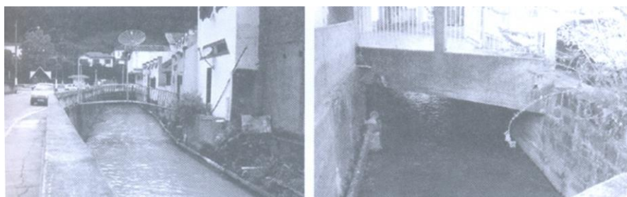
Figura 111: Santa Tereza – Acesso a edificações Fonte: SILVA, 2007, p. 179.
