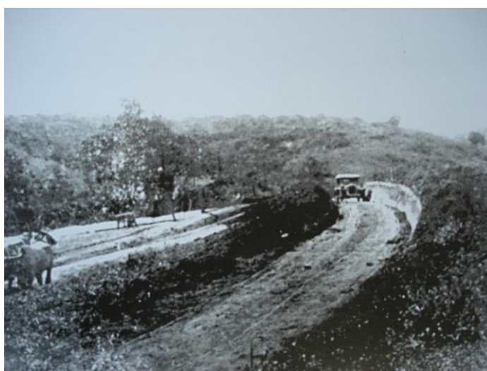
Figura 30: Estrada Vitória-Serra, 1926 – autor não identificado Fonte: BARROS, 2002, p. 101.
