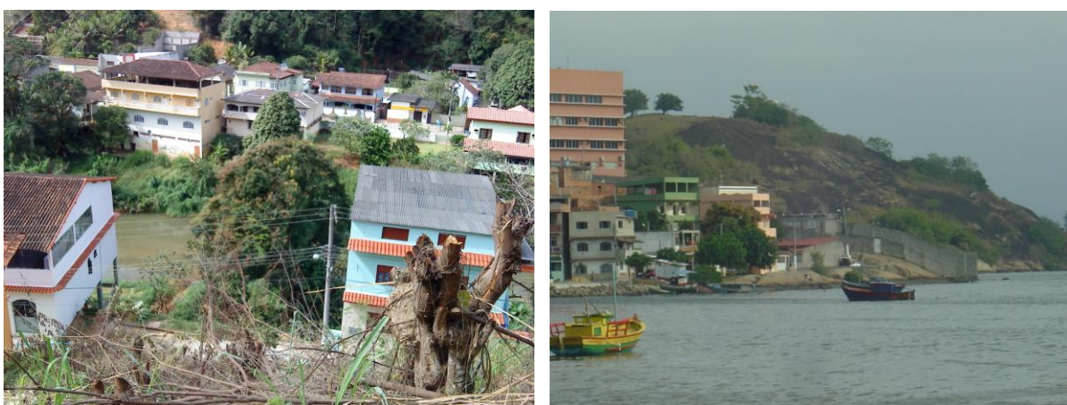
Figuras 207 e 208: Edificações às margens do curso d'água, em Santa Leopoldina e Ilha das Caieiras, respectivamente – desconsideração das APP's Fonte: Arquivo pessoal, 2009 e 2008, respectivamente.
