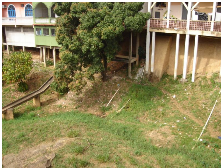
Figura 127: Esgoto eliminado diretamente no rio, por uma edificação mais no interior da área urbana Fonte: Arquivo pessoal, 2009.
