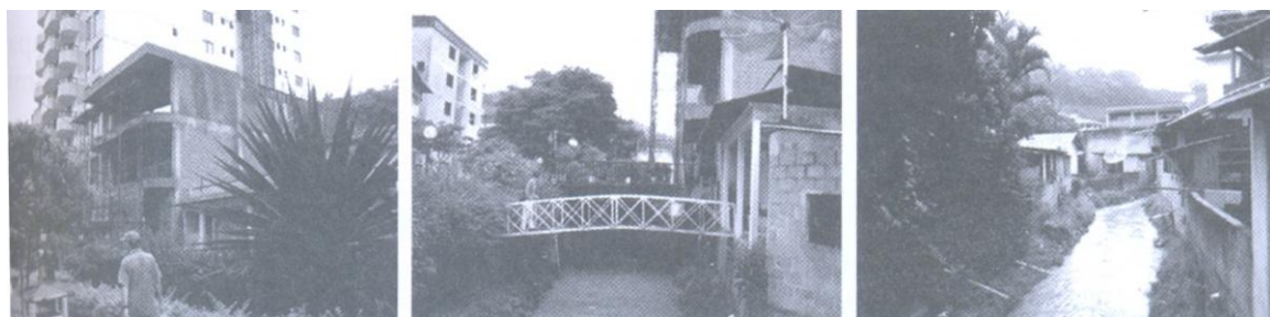
Figura 110: Sede Municipal de Santa Maria de Jetibá – edificação de 10 pavimentos sobre o Rio Santa Maria Fonte: SILVA, 2007, p. 179.
