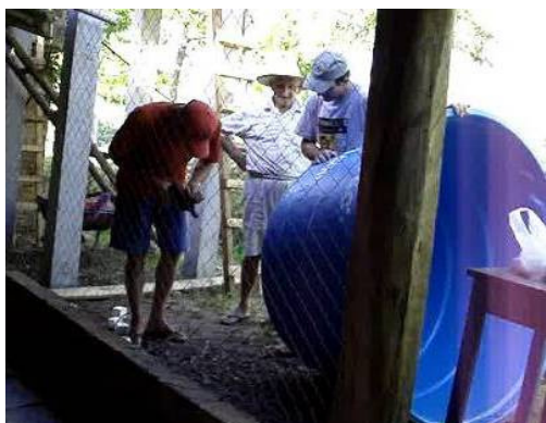
Figura 36 – Preparação para instalar a caixa d'água. Seu Guido Bulligon ao fundo.
