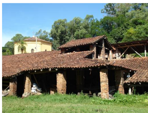
Figura 12 – Ao lado da igreja, a olaria (desativada) onde os tijolos usados na construção foram fabricados.
