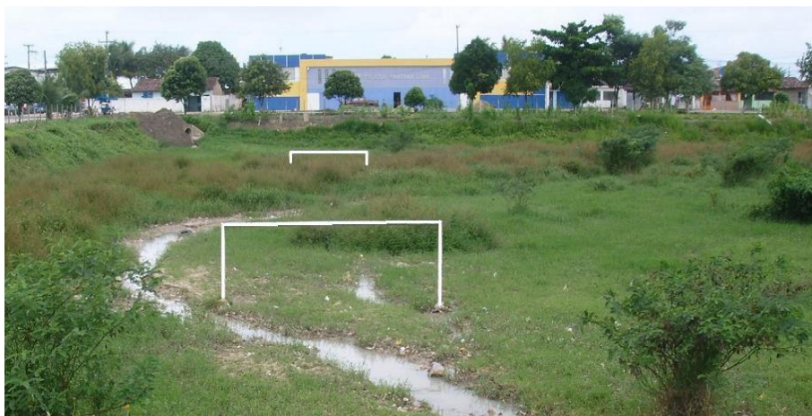
Ilustração 3.12: Campo de pelada permanente situado no interior da lagoa de acumulação na área de macro drenagem, Graciliano Ramos, no bairro Cidade Universitária, Maceió. Foto: Faria, Geraldo. 2008.
