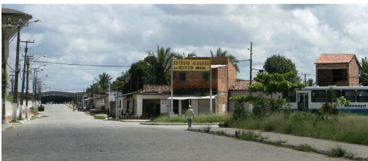
Ilustração 4.37: Adutora do Pratagy à esquerda da avenida Bulhões, à direita uma placa amarela com nome “ Estádio Alegão” e ao fundo a fábrica da Coca-cola, 2009.
