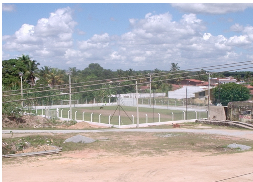
Ilustração 2.13: Espaço livre permeável - o campo de futebol sete society situado no bairro Santos Dumont permite a drenagem das águas pluviais alimentando o aquífero do Catolé. 2009.
