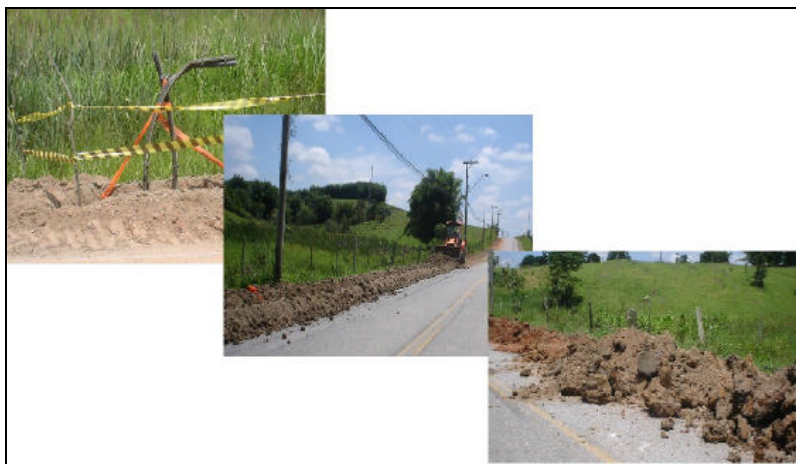
Figura 4.10 Implantação de rede de fibra óptica entre São José e Caçapava passando pelos loteamentos fechados Espelho D'água e Colinas do Parayba.
