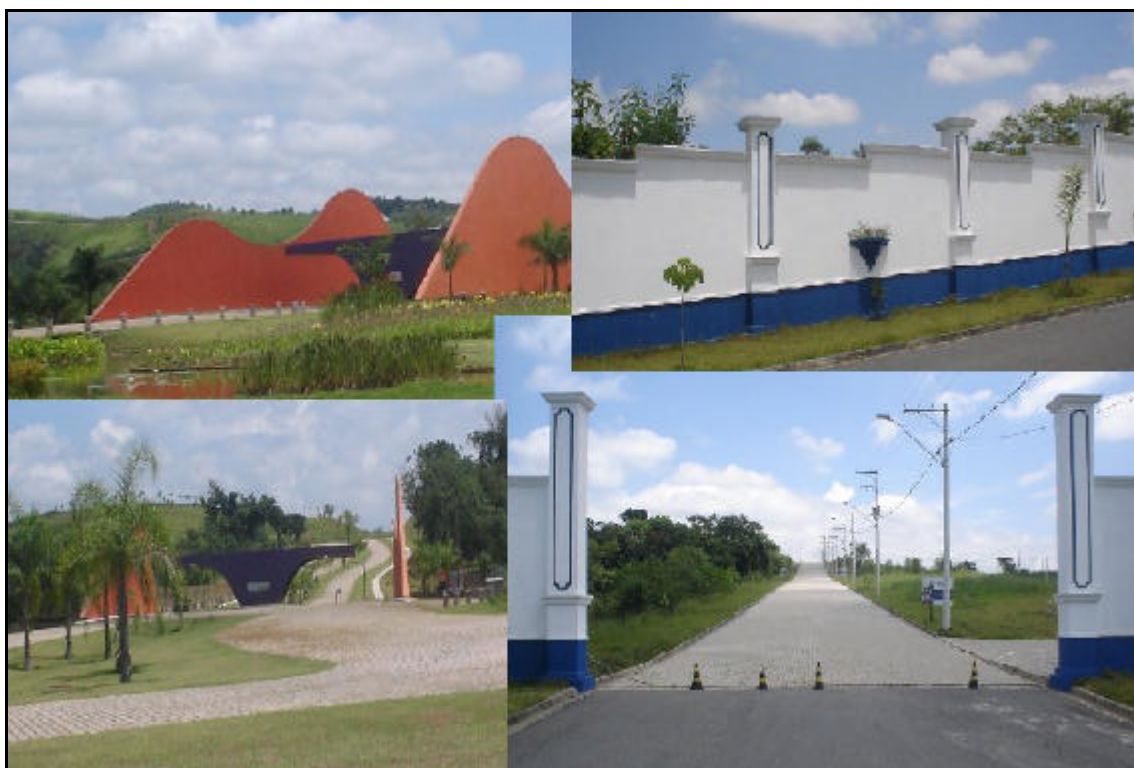
Figura 4.8 Portaria e detalhes dos loteamentos fechados Espelho D'água e Colinas do Parayba
