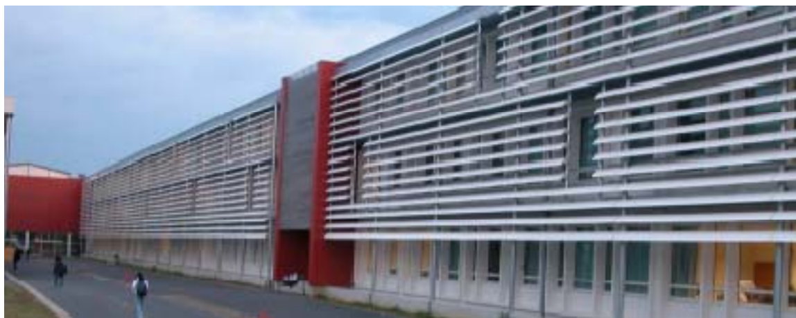
Figura 33: Inserção de brises na fachada do edifício Liceu Chevallier, construído em 1959 e reabilitado em 2006. Fonte: BASTOS, QUEIRÓS-GUADIN e GAUDIN, 2007.
