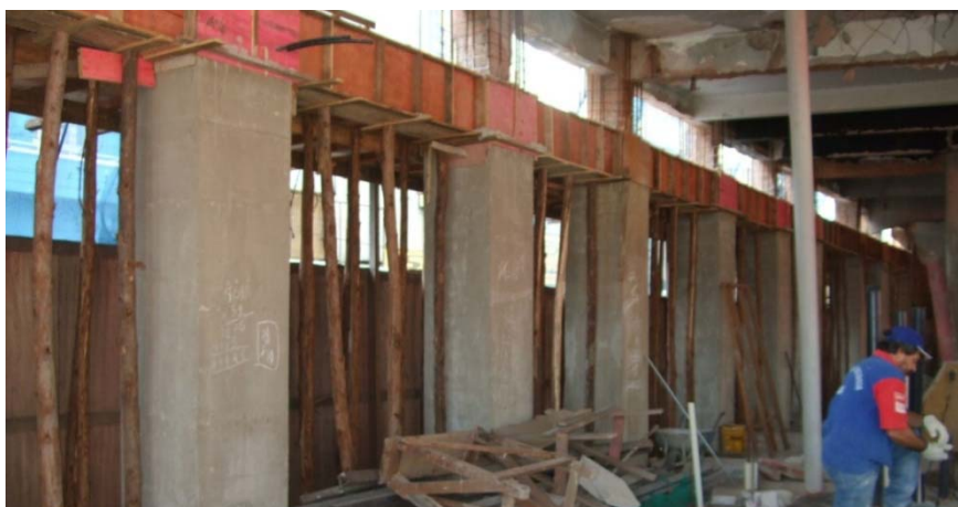
Figura 30: Reforço estrutural realizado nos edifício Pouso Real e Tabajara (2009)
