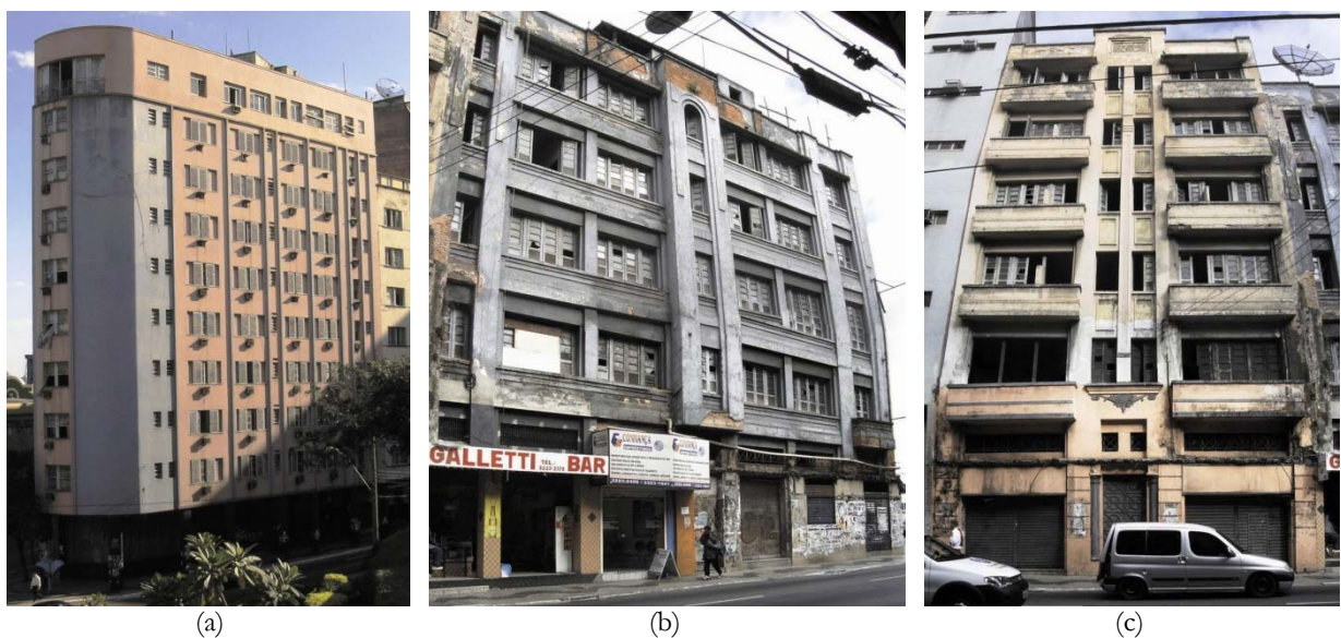
Figura 20: Edifícios em reabilitação na primeira fase do Programa Morar no Centro: (a) Ed. Estoril; (b) Ed. Pouso Real; e (c) Ed. Tabajara (200?).
