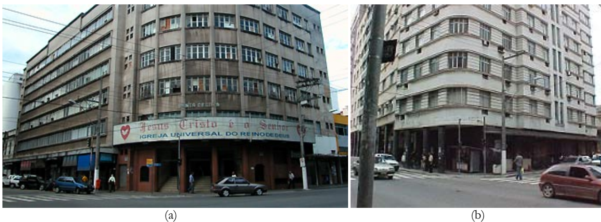
Figura 21: Edifícios a serem reabilitados na próxima fase do Programa Morar no Centro: (a) Edifício Santa Cecília; (b) Edifício José Lourenço Costa Aragão (200?)
