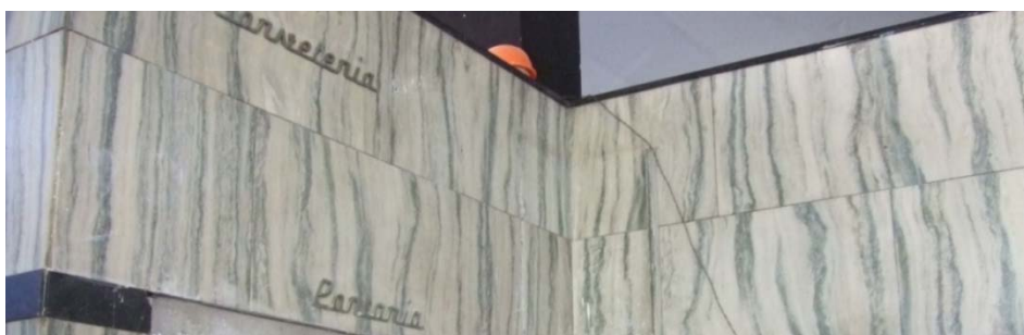
Figura 35: O revestimento em mármore do pavimento térreo foi mantido no edifício Estoril (2009)
