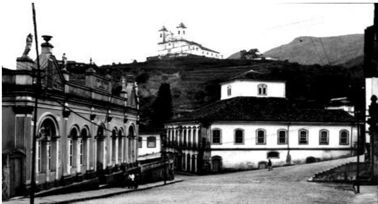
Prédio do Liceu – à esquerda – sem data
