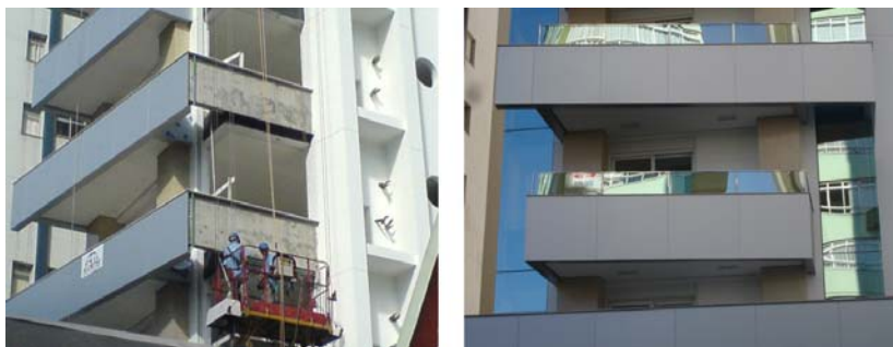
Figura 4.74 a- etapa de aplicação de ACM e b- acabamento da fachada Sul.
