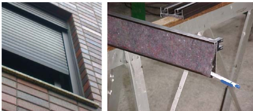
Figura 4.53 a- esquadrias dos dormitórios e b- revestimento acústico interno
