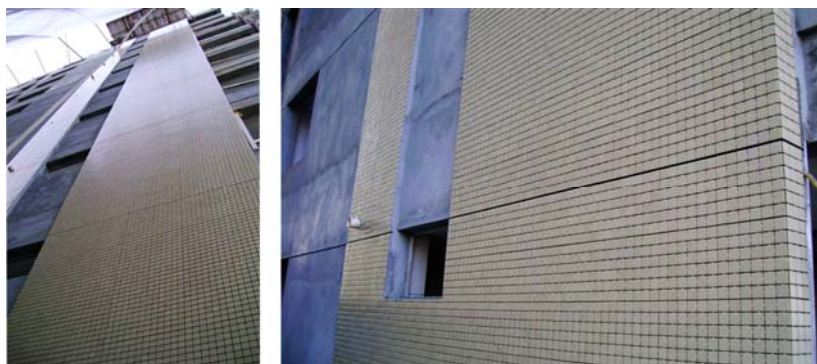
Figura 4.73 a- aplicação com andaimes e b- junta de dilatação entre as pastilhas.
