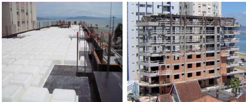
Figura 4.70 a- cubetas plásticas da laje alveolar e b- execução das vedações.
