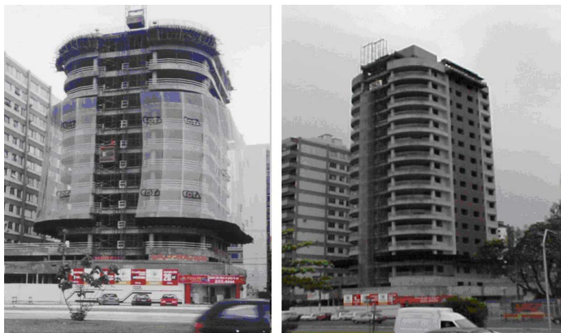
Figura 4.47 a- concretagem da laje e b- fase de revestimento do edifício.
