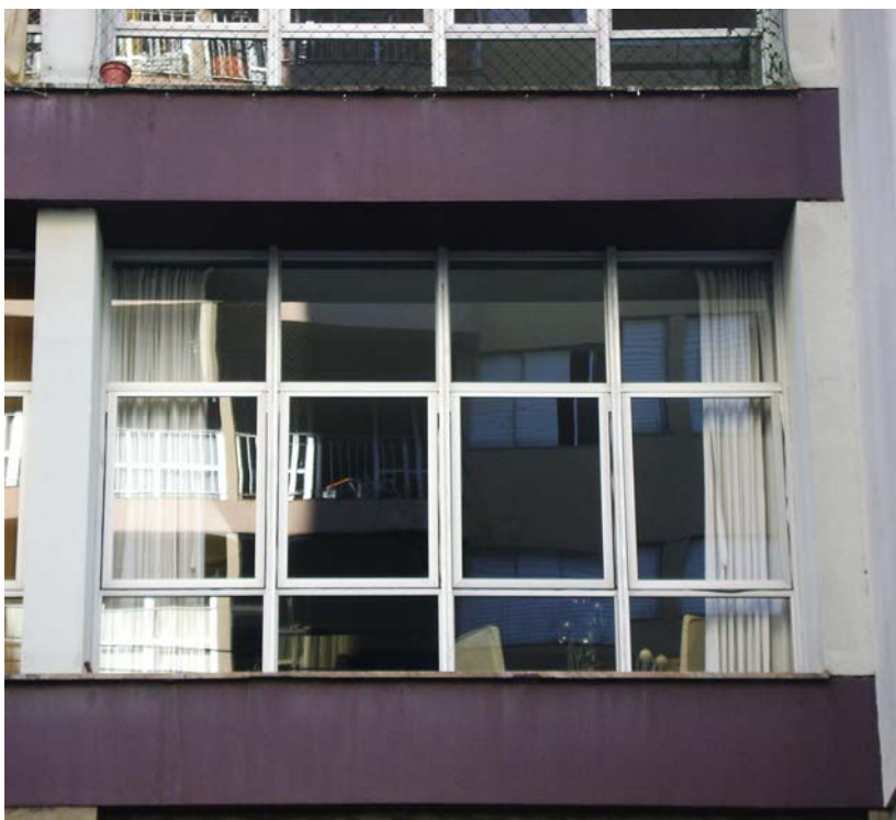
Figura 4.26. Vista das esquadrias da sala de estar da fachada Norte
