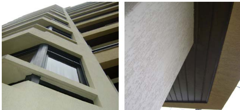
Figura 4.37 a- revestimento externo tipo grafiato e b- pilar e viga com grafiato .
