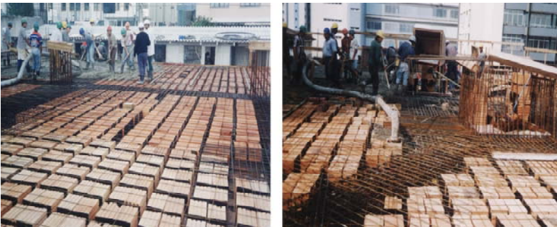
Figura 4.49 a- laje nervurada e b- viga chata
