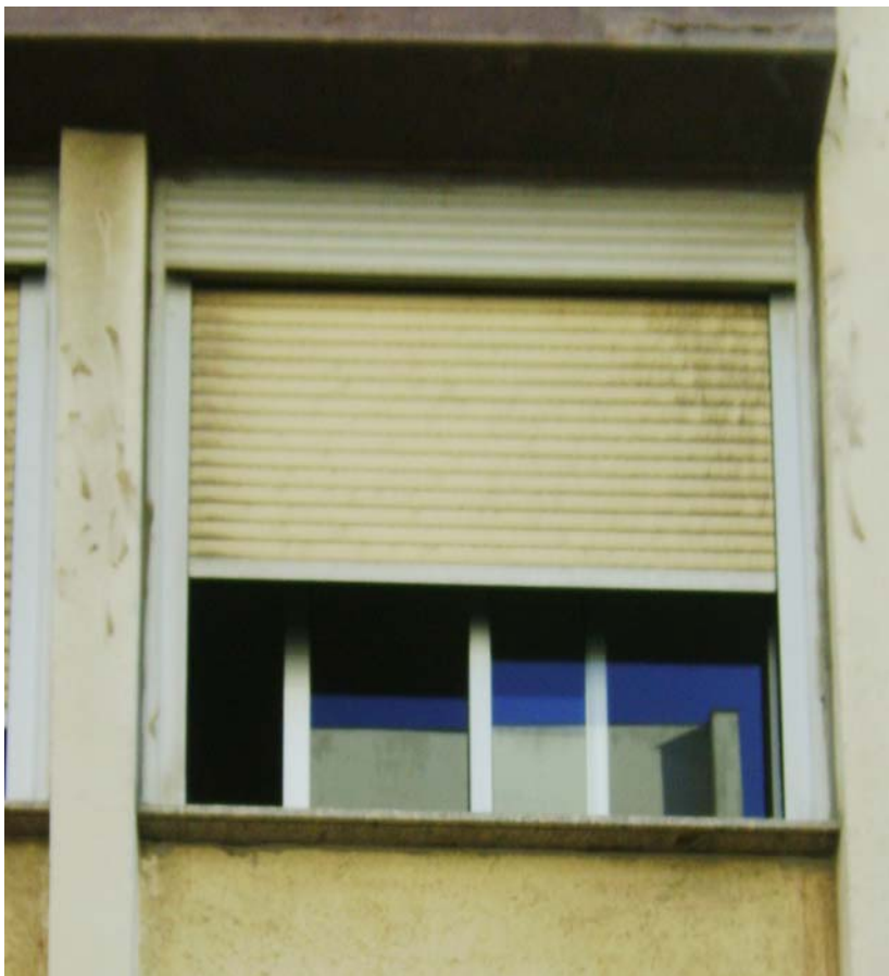
Figura 4.28. Vista das esquadrias dos dormitórios da fachada Leste e Oeste
