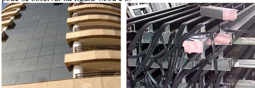
Figura 4.55 a- pele de vidro na fachada e b- montantes e baguetes com lã de rocha
