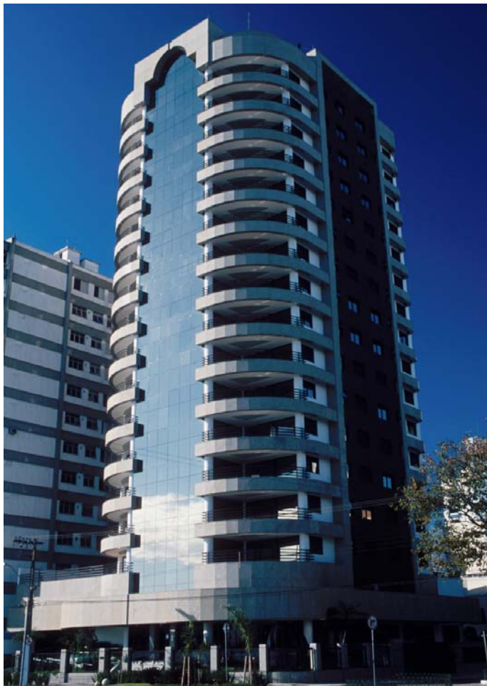
Figura 4.40. Perspectiva da fachada frontal do Residencial Porto Régio
