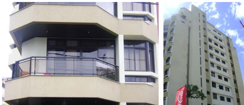
Figura 4.36 a- vista da fachada Norte e b- vista da fachada Oeste.
