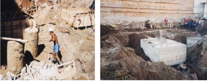
Figura 4.48 a- arrasamento das estacas e b- blocos de fundação em concreto armado.
