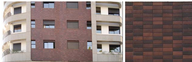
Figura 4.52 a- fachada oeste e b- detalhe do revestimento cerâmico.
