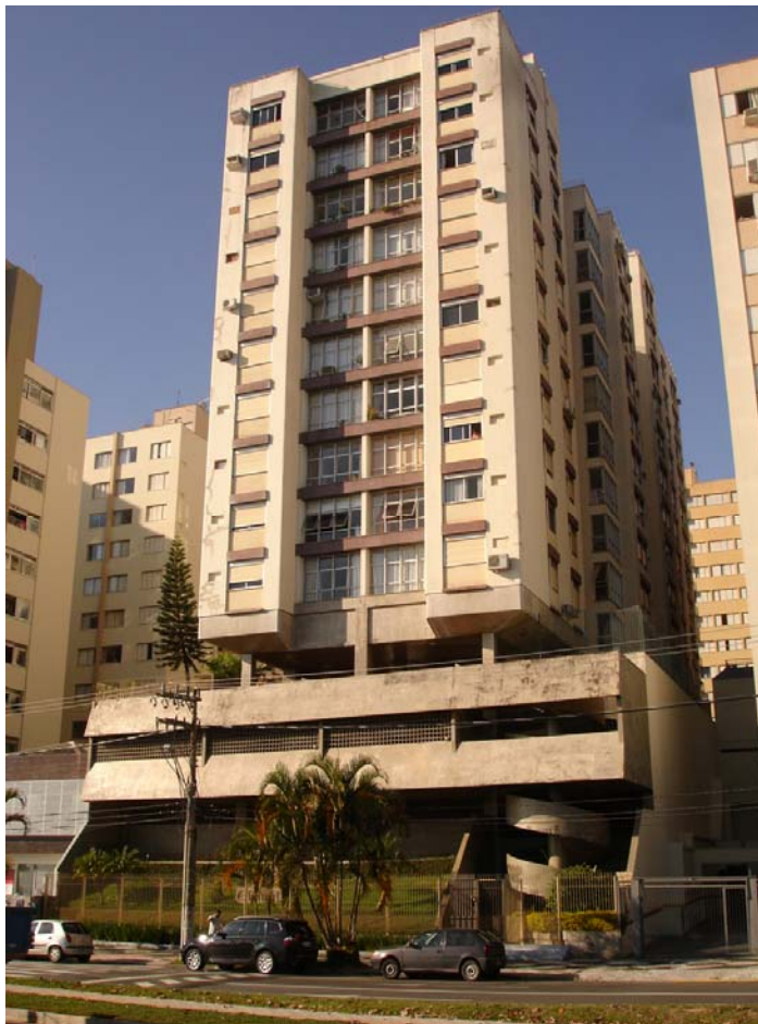
Figura 4.15. Perspectiva da fachada Norte do Residencial Gemini I e II
