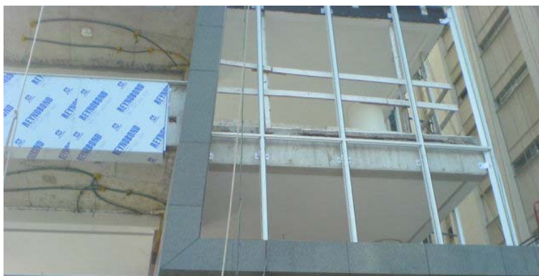
Figura 4.76. Estrutura dos perfis de alumínio fixados nas vigas de borda.
