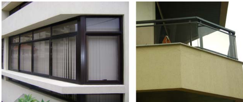
Figura 4.38 a - esquadria da sala de jantar e b- guarda corpo de vidro.
