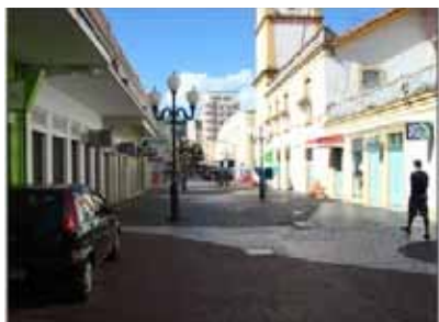
Figura 28: Trecho do calçadão da Rua Felipe Schmidt sem piso tátil direcional (a)
