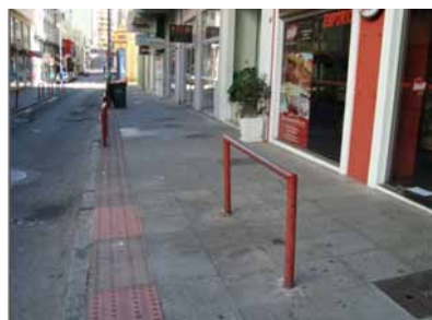
Figura 32: Guard-rails desprovidas de piso tátil de alerta.
