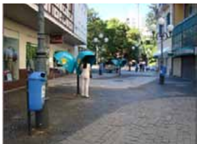
Figura 26: Equipamentos anulando as rotas seguras (a).
