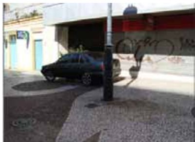
Figura 24: Trecho do calçadão da Rua Felipe Schmidt com ressaltos e desníveis no piso (a).
