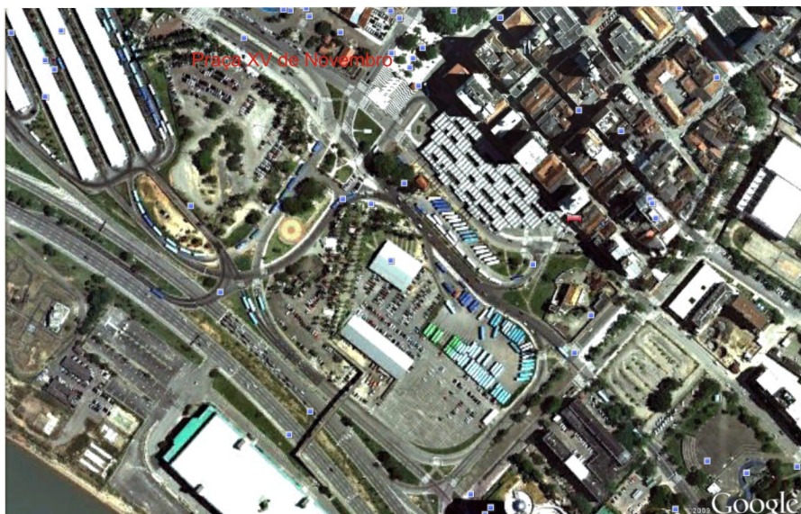
Figura 3.12 – Aterro da Baía Sul Fonte: Google Earth em 9 jan. 2009
