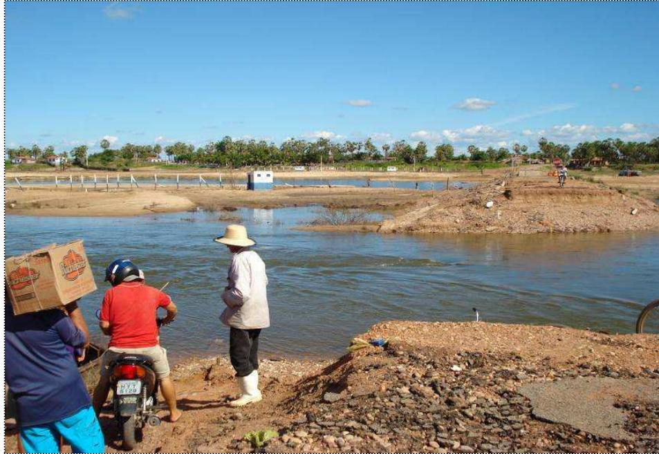
FIGURA 51 – Rompimento da passagem molhada Tabuleiro/Limoeiro.
