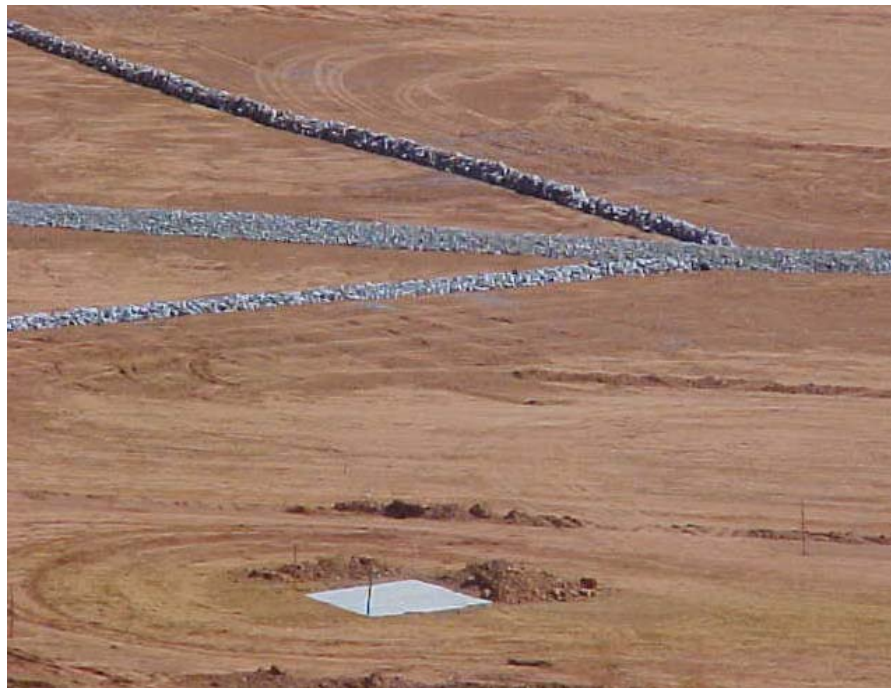
Figura 11 – Detalhe dos drenos instalados na base do aterro no formato “espinha de peixe”. Fonte: CRVA (acervo fotográfico) / 2003
