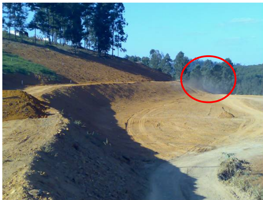
Figura 19 - Emissão de gases após ser queimado do biogás na saída do dreno
