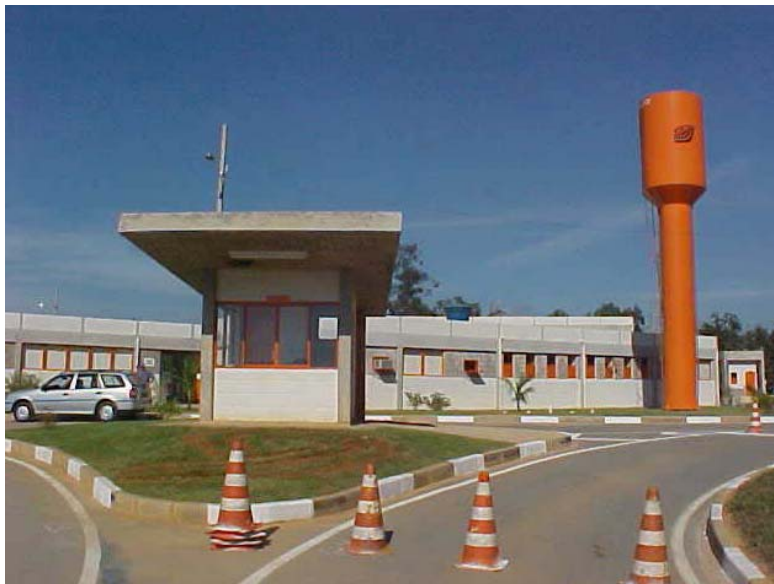
Figura 12 – Vista parcial da área de entrada da CRVA com guarita, ao fundo prédios administrativos e reservatório elevado de água (julho/2009).
