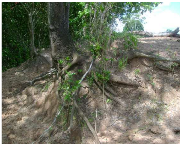
Foto 17: processo erosivo nas margens do RCT. Ponte da rodovia MS 320 Souza, 12/2006
