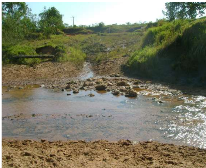
Foto 12: Assoreamento e processo erosivo às margens do RCT no distrito de Garcias Lat. 20° 35'50.5" S - Long. 52° 13' 02.1" W Souza 08/2007
