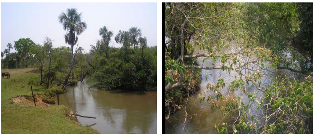
Fotos 5 e 6: RCT – Aspectos do RCT na ponte do distrito de Arapuá Lat. 20°39'41''S – Long. 52° 01'43''W Souza, 09/2007
