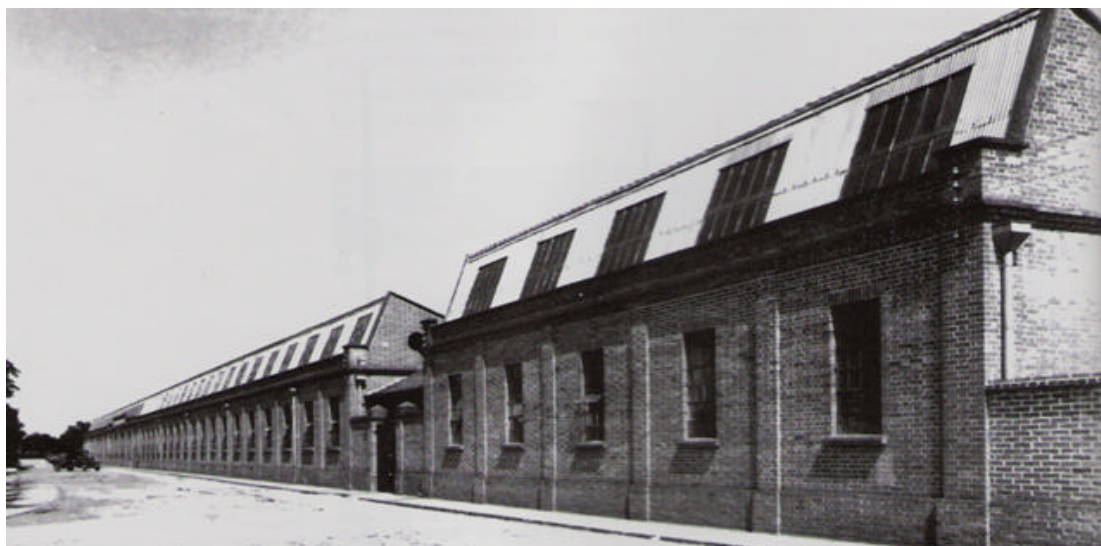
Figura 4.5: Vista da face frontal da Tecelagem Parahyba, década de 1930 Fonte: Santos (2006)
