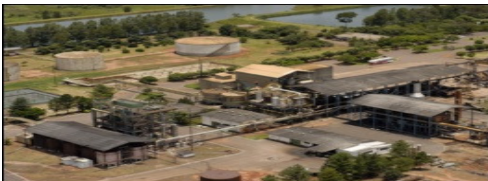
Figura 3 – Vista aérea da Usina Mundial, Mirandópolis, 2008.
